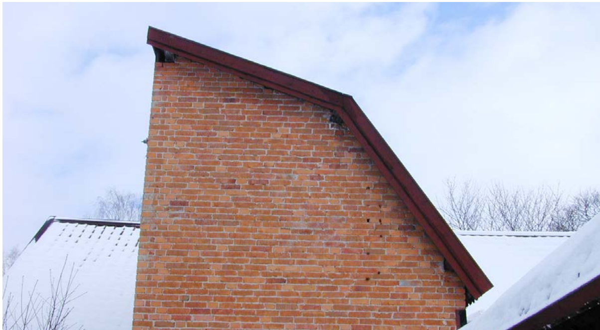
61 Transformatorbyggnaden med sitt tidstypiska tak i sen jugendstil som skvallrar om att byggnaden är uppförd under 1910-talet.
