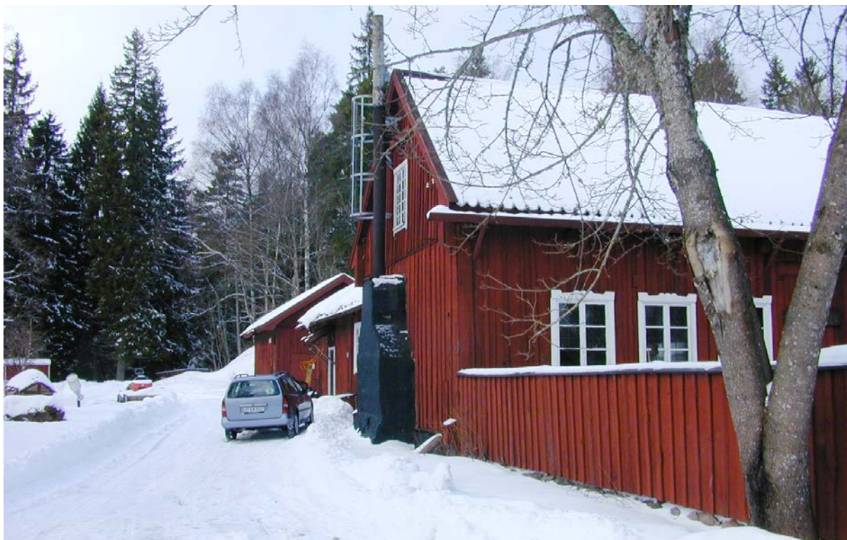
57 Maskinverkstaden från öster. I bakgrunden skymtar maskinverkstaden respektive drivmedelsförrådet. Maskinhusets skorsten har uppförts sedan byggnaden omdanats till restaurang.
