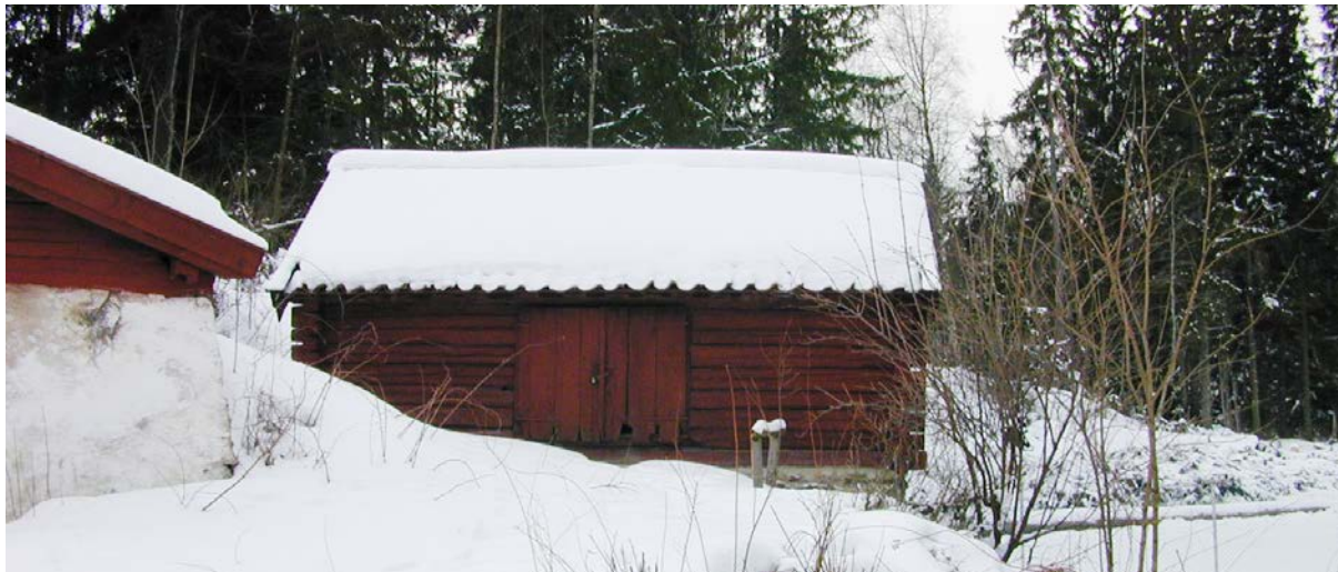
68 Krutkällaren från öster. Byggnaden har i sen tid benämnts mangelboden. Överbyggnaden har troligen haft denna funktion under någon period.
