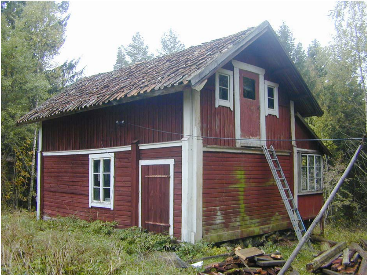
82 Bostadshuset från nordost. Blandningen av konstruktionsteknik där bottenvåningen är timrad medan vindsvåningens väggar är uppförda som regel eller stolpverk antyder att byggnaden förhöjts vid något tillfälle.
