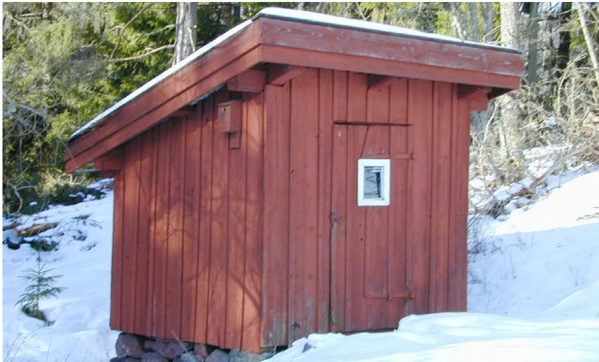
78 Dasset från sydost.
