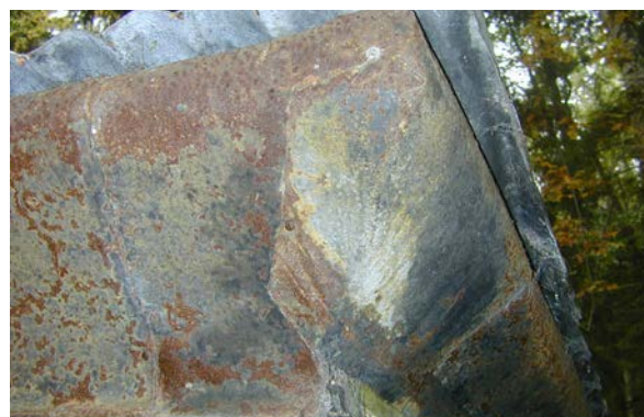
44 Takfotens plåtinklädnad. Det sinuskorrugerade plåttaket syns i bildens ovankant.
