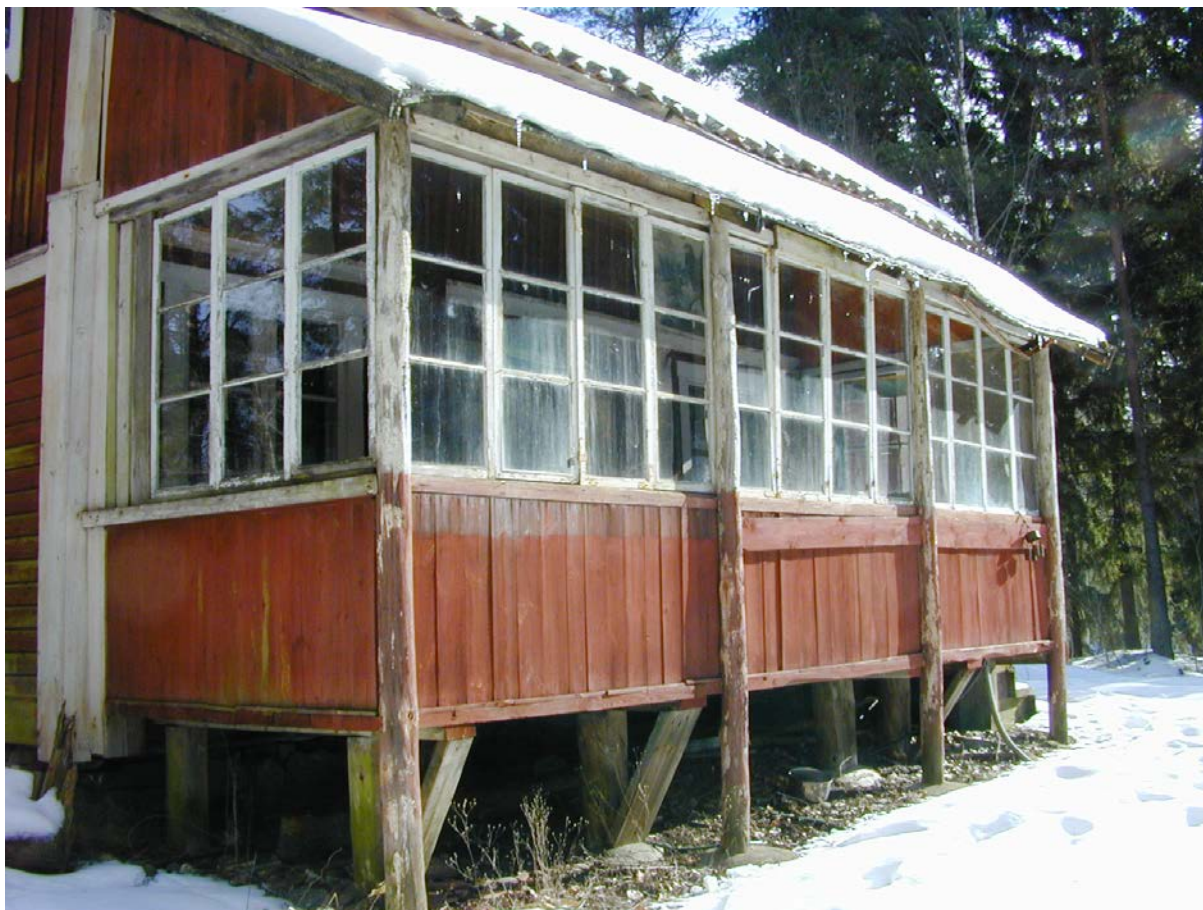
83 Verandan är uppförd 1957 enligt ristning i betonggjutningen till en av grundläggningsstolparna.
