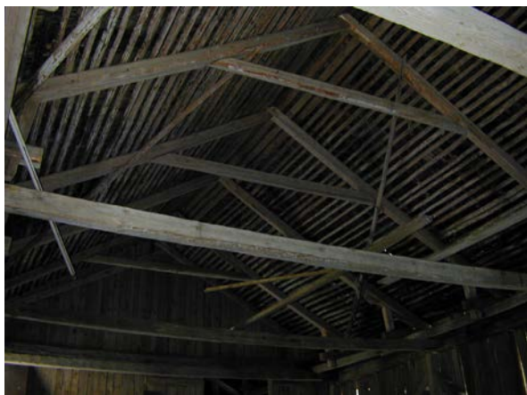
87 Interiörbild, taket sett från höskullen. Byggnadens undertak utgörs av stickspån vilka spikats på bärläkt av kluvet rundvirke.
