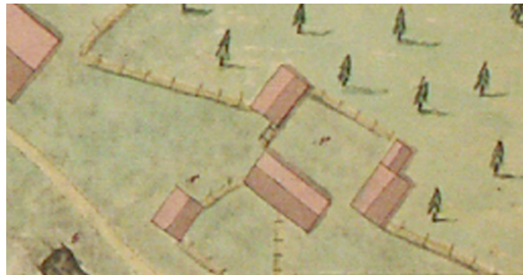
86 Den fågård som fanns vid 1798 års kartering låg på samma plats som den nuvarande. Vid denna tid var den dock utformad som en kringbyggd gård. Det är tänkbart att huvudparten av byggnaden längst t.h. i bild kan ingå som en del i den nuvarande längan.
