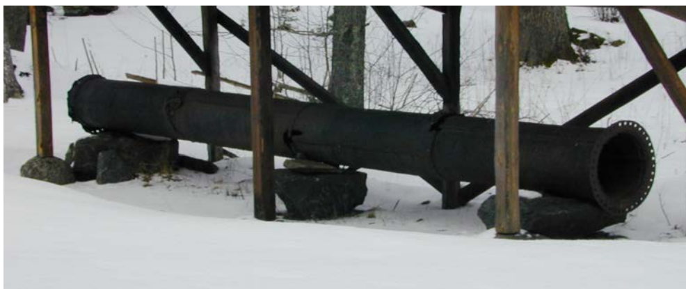
29 Nitat rör under skyddstak.
