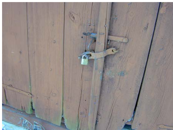
70 Handsmida och möjligen ursprungliga beslag på dörren till källarens timrade överbyggnad.
