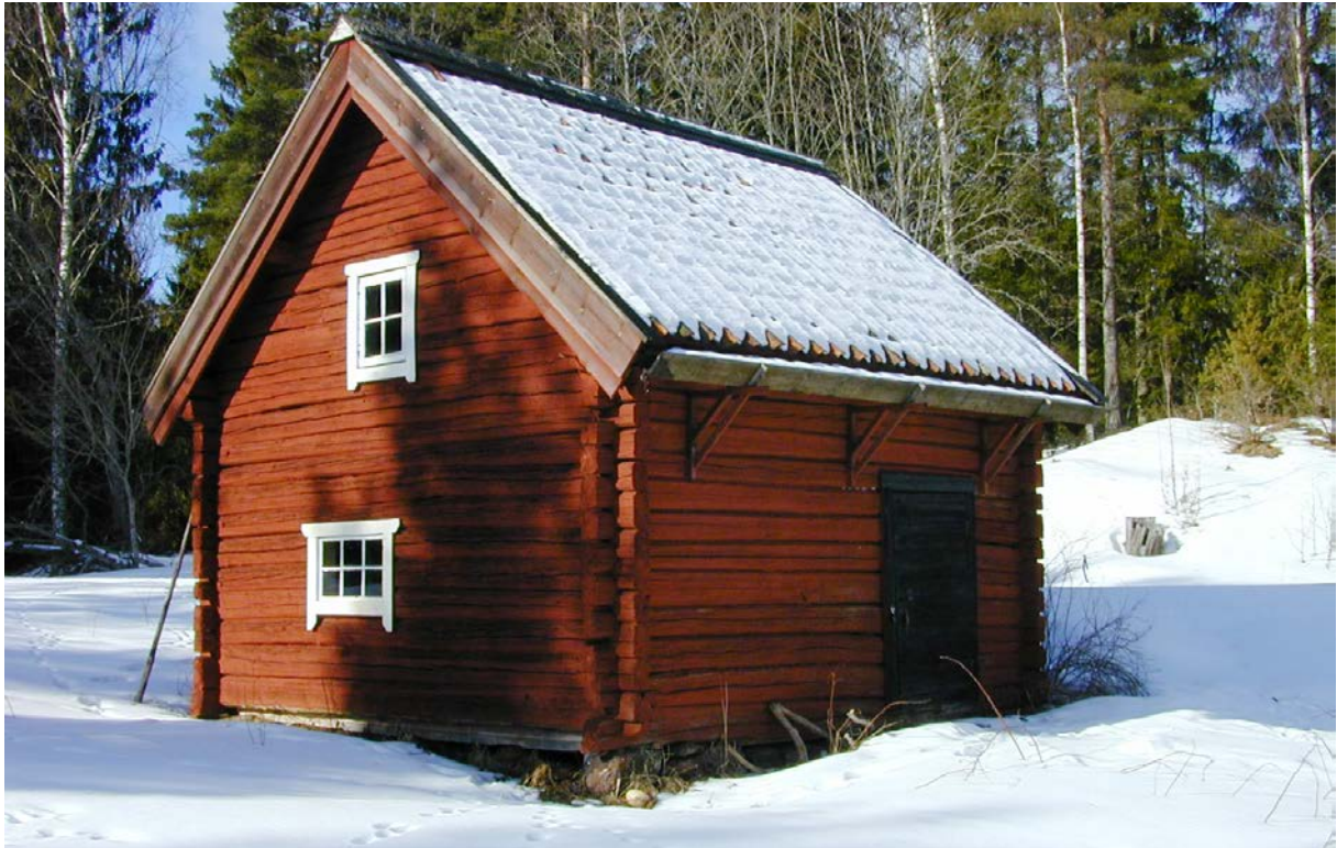
79 Magasinsbyggnaden från sydost, år 2004.
