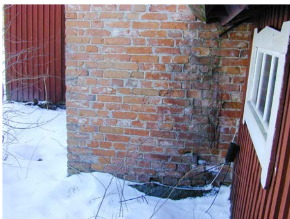
62 Transformatorbyggnaden, frostsprängt murverk till följd av bristfällig takavvattning på intilliggande byggnadsdel (farstu).
