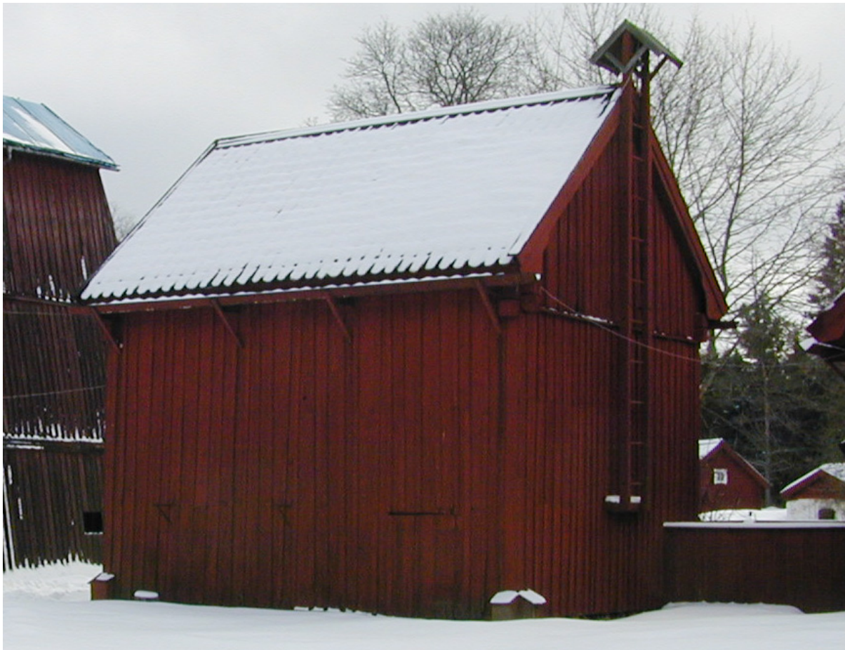
63 Förrådsbyggnaden från norr.
