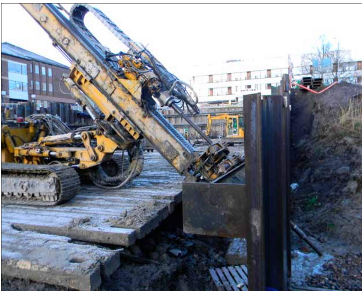
Figur 5. Den planerade byggnationen krävde bakåtförankrad stålspont för schaktgropen, vilket innebar borrhning av staghål genom kulturlager, med självborrande stag i cirka 45 graders vinkel ner i marken på spontens baksida. Foto: Björn Pettersson 2014, Sörmlands museum.
