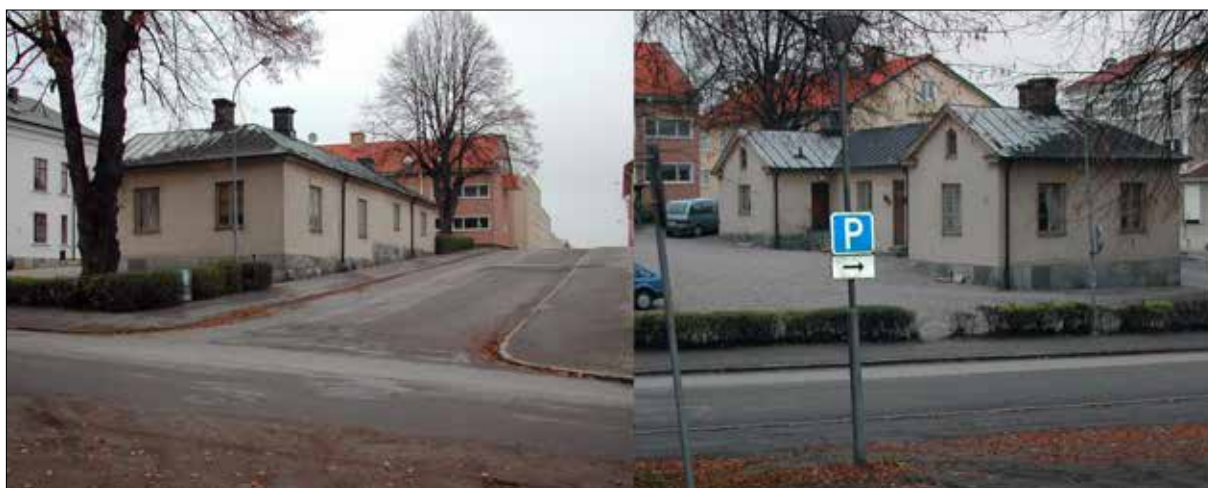
Figur 2. Gårdshuset före rivning. Till vänster mot norr och till höger mot ostnordost. Foto: Lars Norberg 2003, Sörmlands museum.
