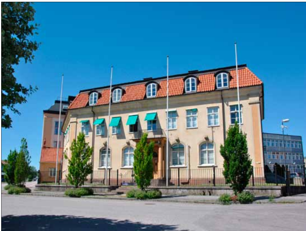
6. Byggnad 1, fasad mot söder 2015. (SLM 2015-977)
