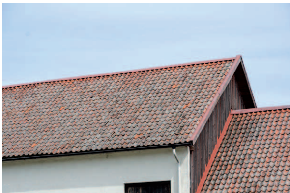
Takfallets östra del. (D2015-1010)
