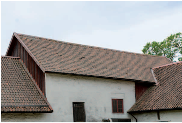
Det inre takfallet på den höga delen. (D2015-1014)
