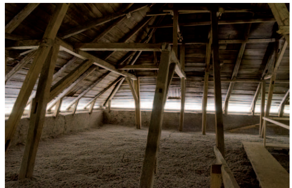
Hörnet mot den norra längan har en något märklig sammansättning vilken syns närmst i bild. Möjligen har ladugårdens längor höjts vid olika tillfällen och anslutningarna då sett annorlunda ut. (D2015-1069)
