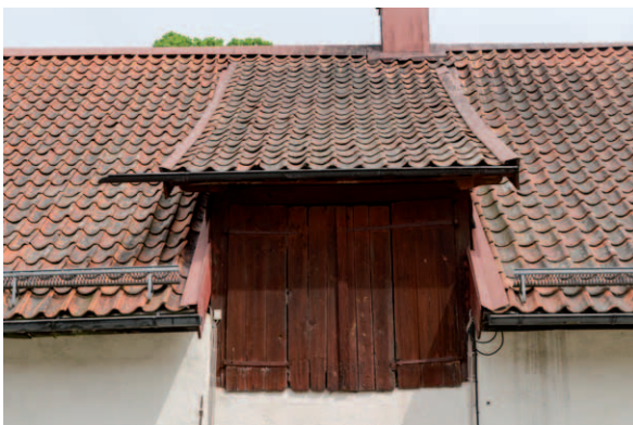
Den mittersta takkupan som bryter takfoten. Notera den utskjutande hängrännan som avleder vattnet åt ena sidan. (D2015-1033)
