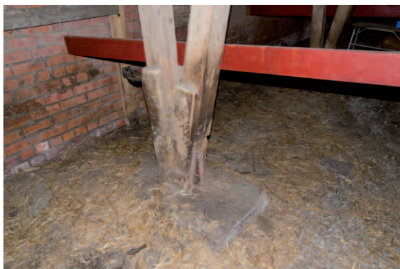
Takstolarna vilar på gjutna betongsulor i marken. (D2015-1055)
