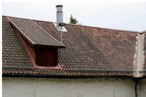
Den södra takkupan. (D2015-1046)
