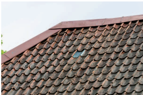
Pannan av glas nära det nordvästra hörnet. (D2015-1022)
