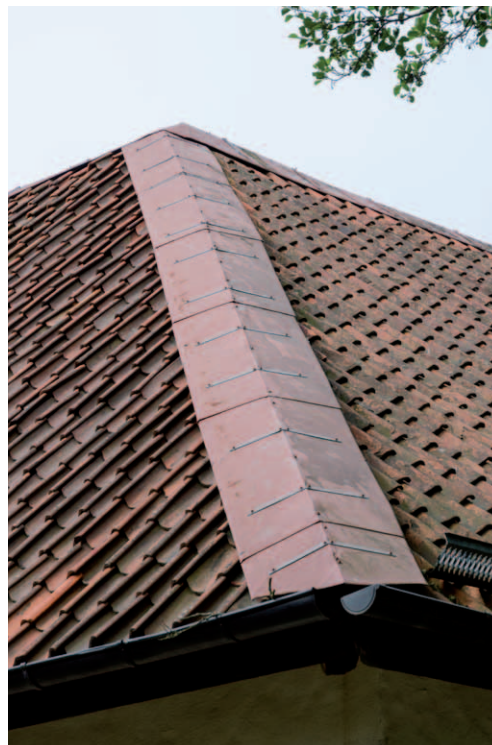
Plåt över vinkeln vid det nordöstra hörnet. Notera beslag och fästpunkter. (D2015-1075)
