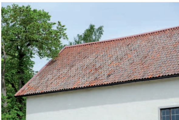
Takfallets västra del. (D2015-1011)
