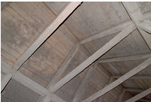
Innertaket samt den övre bindbjälken. (D2015-1052)
