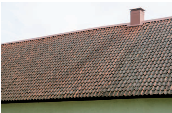
Det västra takfallets mitt. (D2015-1019)
