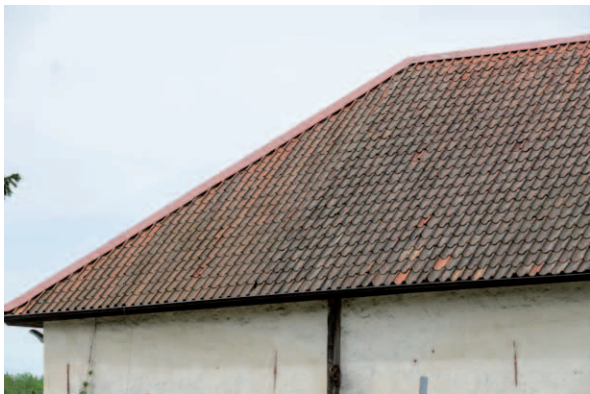
Det södra partiet där alla pannor är utbytta syns som en svag lodrätt färgskiftning från nockens hörnplåt. (D2015-1039)
