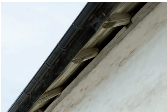
Takfoten är öppen mot vind. (D2015-1004)
