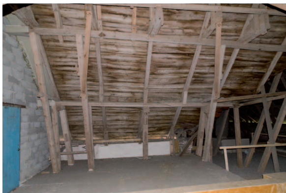
Innertaket åt gården nära den västra längan. Branddörren till vänster leder in till det mittersta vindsutrymmet. (D2015-1065)
