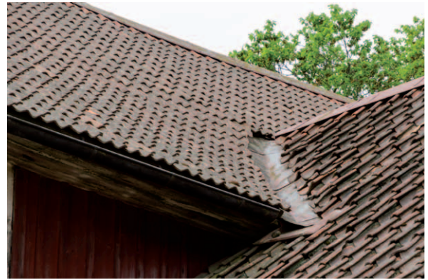
Vinkelrännan mot den västra längan. Denna är mindre iögonfallande än vid de övriga takvinklarna. (D2015-1016)
