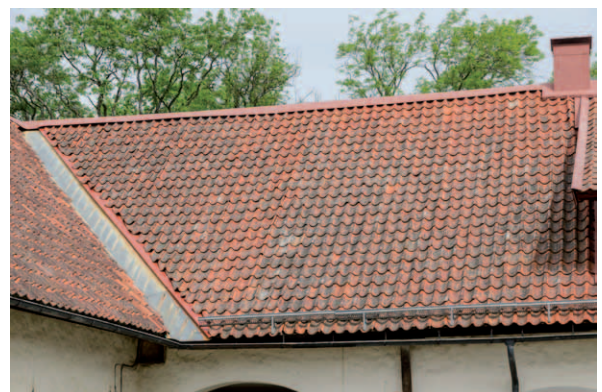
Inre takfallet längst åt väster. (D2015-1036)
