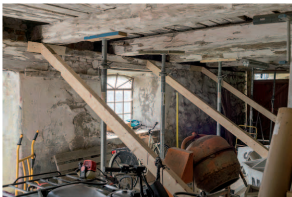
Bjälklaget över kostallet är idag avlastat med byggstämp. (D2015-1056)
