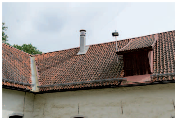
Östra takfallet med den norra takkupan som bryter takfoten. (D2015-1044)
