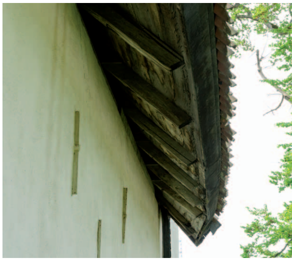
Den öppna takfoten med det nedåtlutande partiet längst bort i bild. (D2015-1018)
