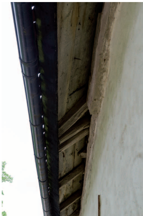
Den öppna takfoten med en sned sparre som hör till östra längans takstol. (D2015-1029)
