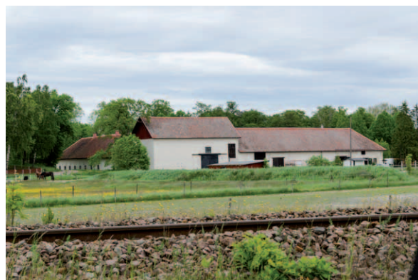
Ladugården sett från järnvägen i sydväst. (D2015-1001)
