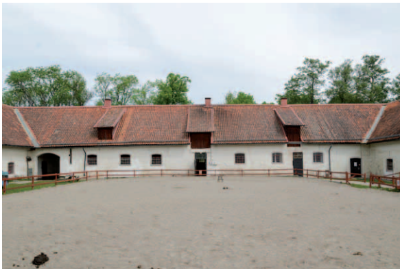
Det norra takfallet. (D2015-1032)
