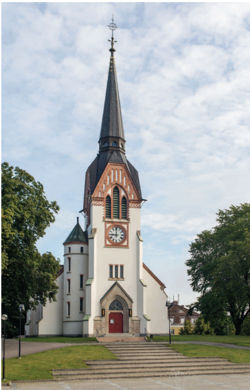
Katrineholms kyrka uppförd 1903 och ritad av Folke Zettervall och Karl Flodin. Kyrkans exteriör bär spår av jugend såväl som nygotik. Notera det påhängda trapphuset till vänster om tornet samt kalkstensportalen. (SLM D2015-1191)
