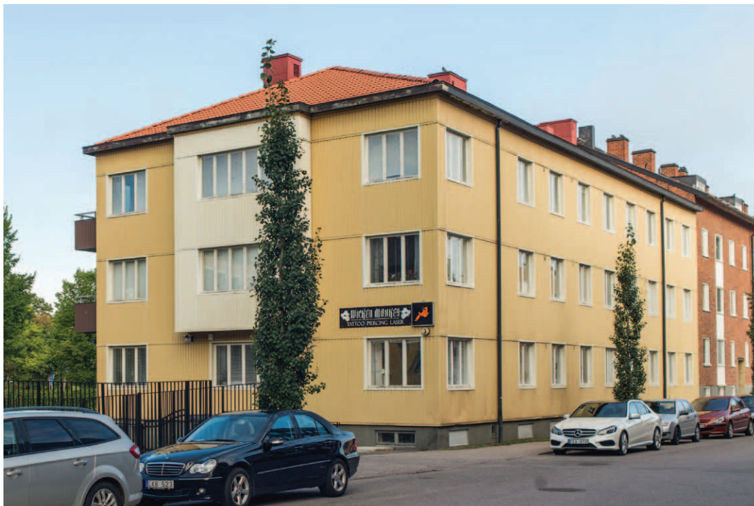
Huset på Alen 4 uppfördes 1939-40. Tomten var tidigare obebyggd. Huset var det första i kvarteret att uppföras i tre våningar istället för två. Trots att fasaden förändrats i samband med en tilläggsisolering 1977 har byggnaden till viss del kvar sitt funktionalistiska formspråk. (SLM D2015-1186)
