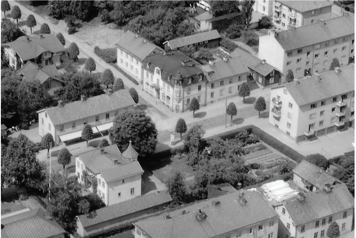
Utsnitt av ett flygfoto taget från öster 1958. Palmen 4 och 3 syns i den övre delen av bilden och Alen 6 i den nedre. Fenix-huset på hörnfastigheten Alen 3 som uppfördes 1903 skiljer sig i utformning mot de äldre husen i samma fastighet men anpassades i skala. Notera gårdsbebyggelsen i båda kvarteren som utgjordes av huslängor i en våning. Sörmlands Museums arkiv. (SLM BF04-1292)
