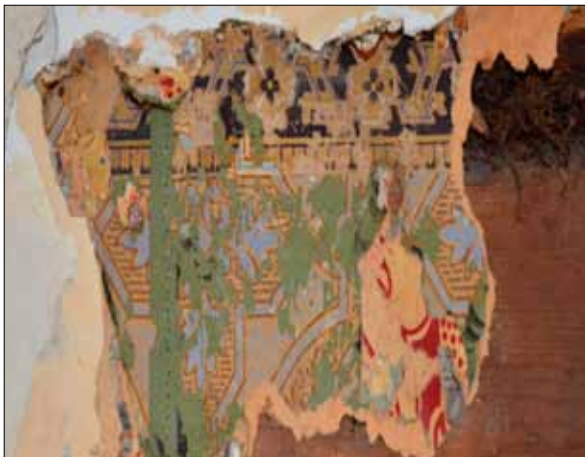
85 Tapetlager i vindsrummet som ligger mot nordost, ca 1870-tal. Notera takbården (Slm D2014-344).
