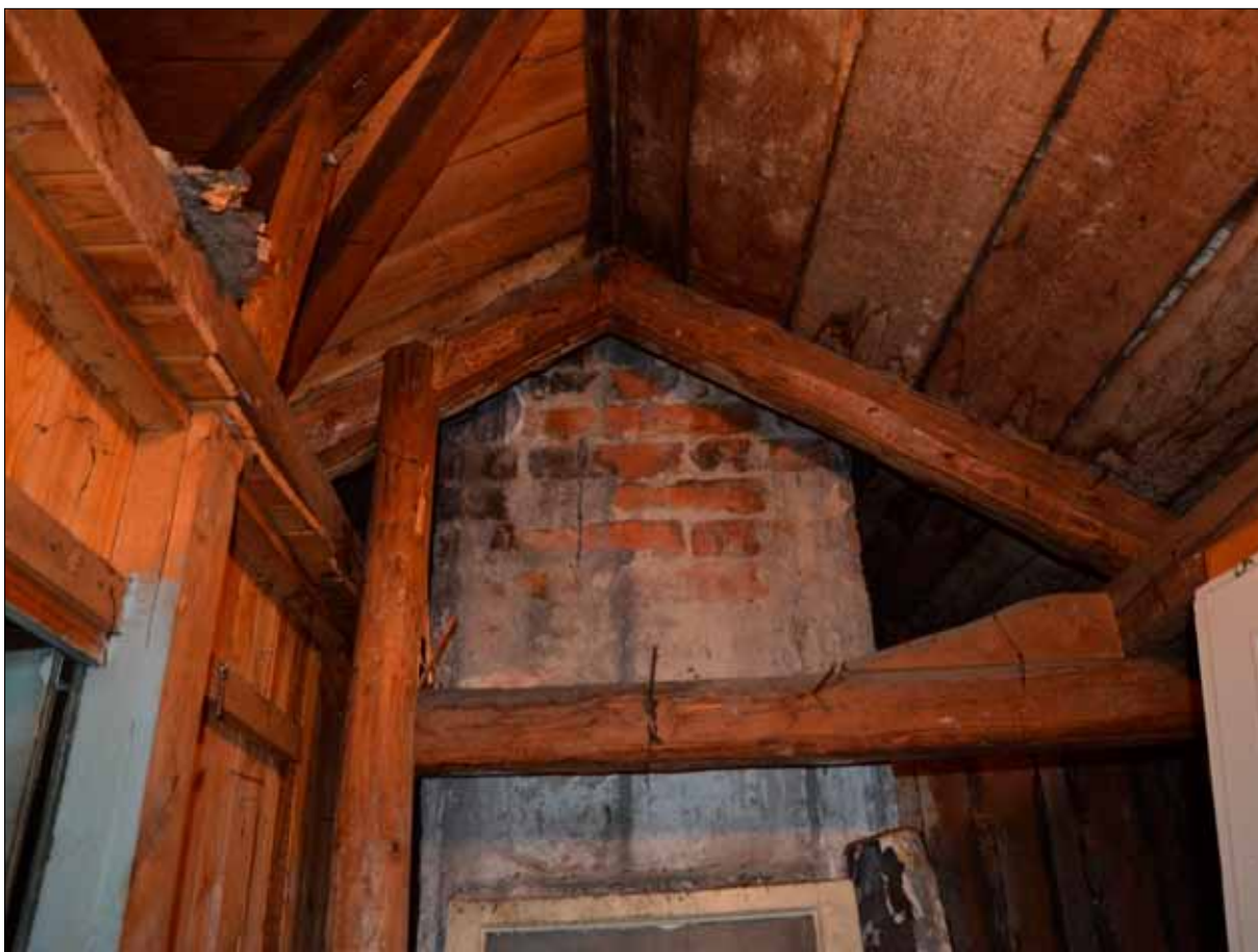
42 Vy upp i vindstaket sett mot norr. På den vänstra stolpen är det skrivet "1895". Till vänster är den tillbyggda delen med trapphus. Ovanpå underlagstaket syns näver, vilket kan anas till höger i bild (Slm D2014-306).
