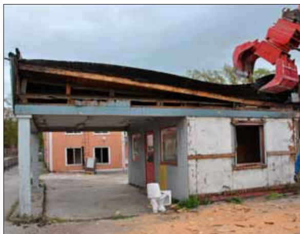
94 Den äldre sadeltakskonstruktionen syntes under den senare uppbyggda "skärmen" (Slm D2014-366).
