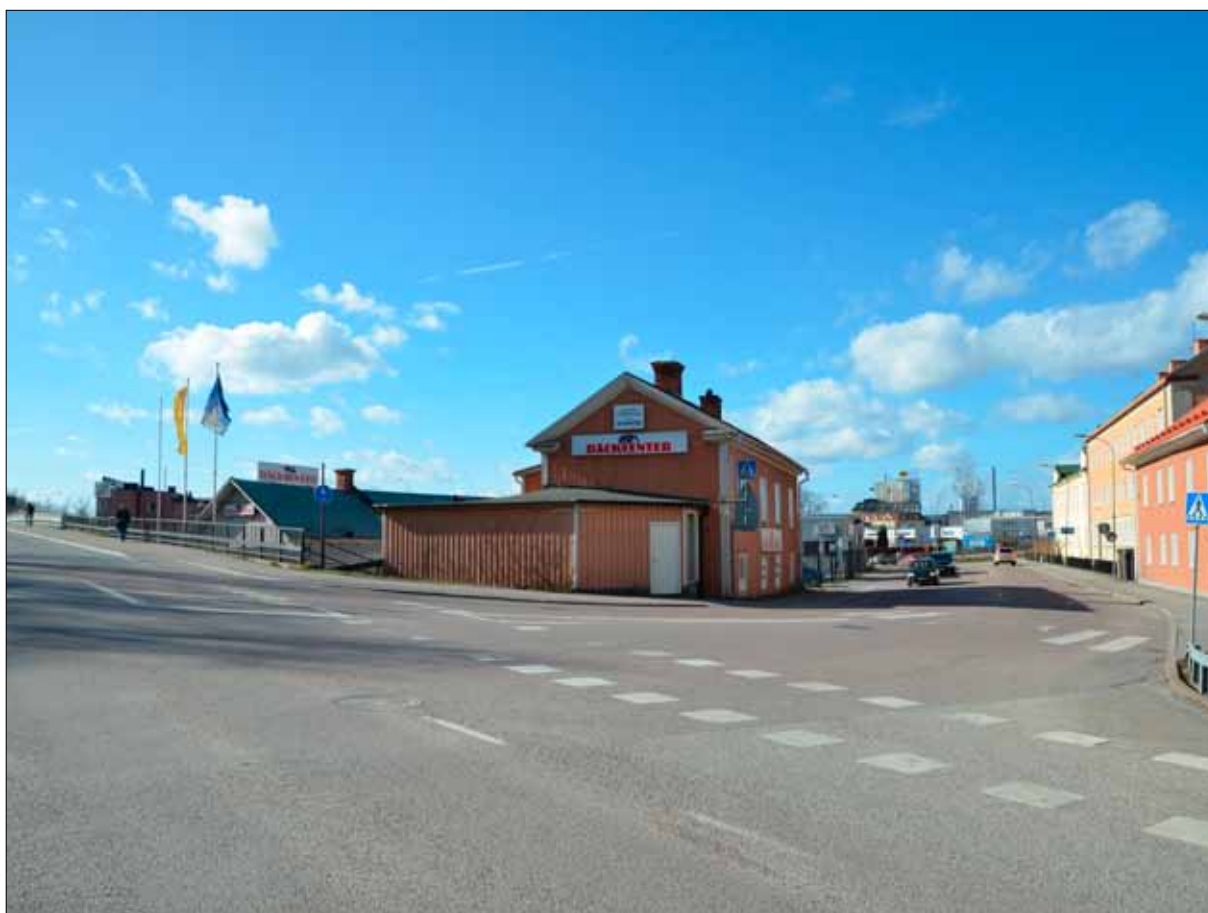
2 Kvarteret Viadukten 3 sett från sydost och Västra Storgatan i mars 2014 (Slm D2014-281).
