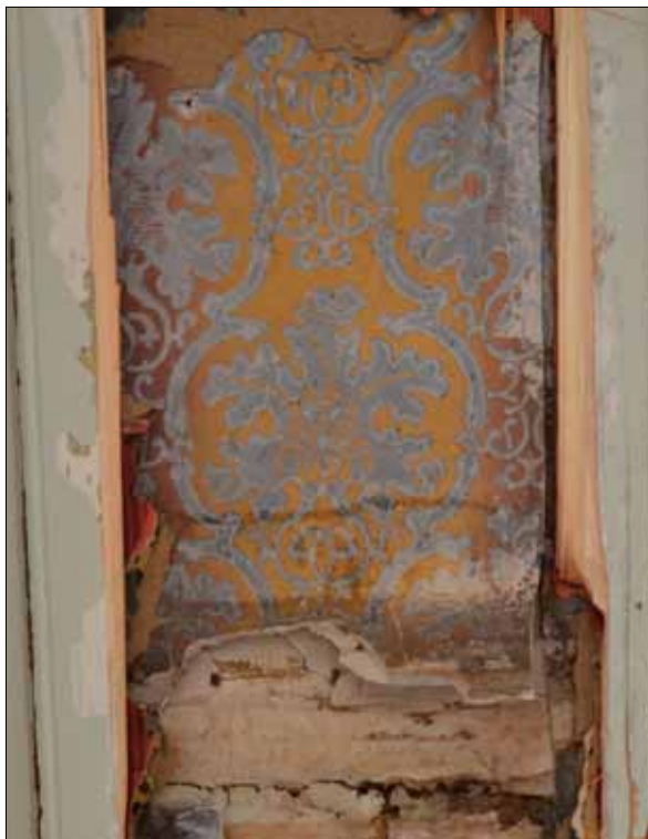
31 I köket, rum 202, sitter grönmålad pärlspontspanel och flera tapetlager. Underst syns en iriserad tapet från 1800-talets mitt (Slm D2014-295).
