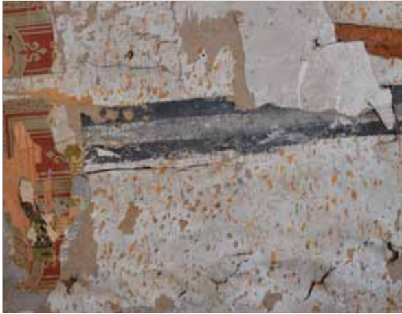
81 Understa stänkmålningen som satt i rum 205 på tidning från 1797. Som bröstning en ca 5 cm bred linje målad i grått och svart (Slm D2014-340).
