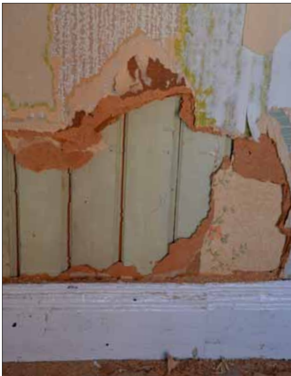
20 Under pappspänning med tapetlager i rum 104 syns den grönmalade pärlspontspanelen (Slm D2014-284).
