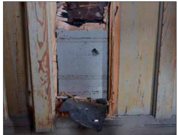
86 Underst den äldsta liggande grönmalade fasadpanelen. Överst den senare breda locklistpanelen (Slm D2014-345).
