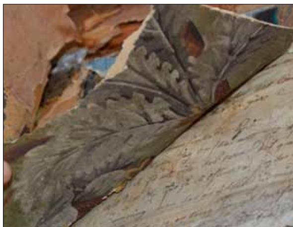
75 Handmålad "felvänd" tapet i rum 202 samt brev från tidigt 1800-tal klistrat direkt på timret (Slm D2014-334).
