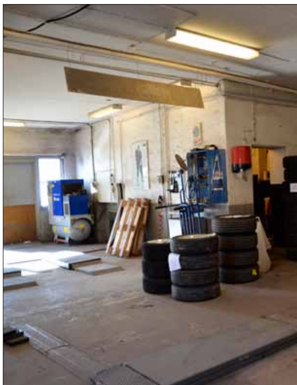
59 Verkstadsbyggnadens interiör från norr (Slm D2014-323).
