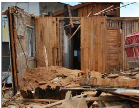
96 Notera väggarnas stående plank och ursprunglig väggyputs på så kallad vassmatta, "rörning", som syns till vänster (Slm D2014-368).
