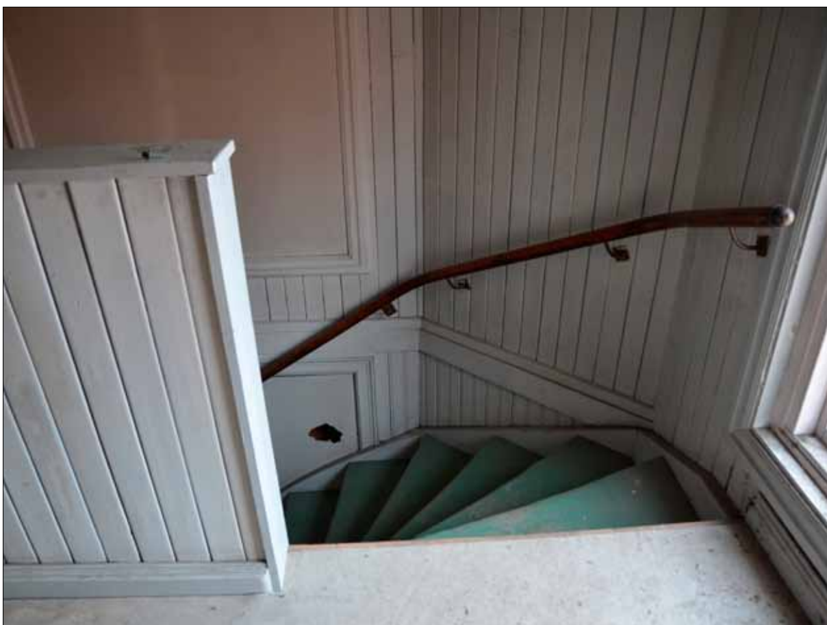
27 Trapphuset i bostadshuset sett från vindsvåningen ned mot farstun på övre våningen. Ramarna i väggen markerar äldre fönsteröppningar (Slm D2014-291).
