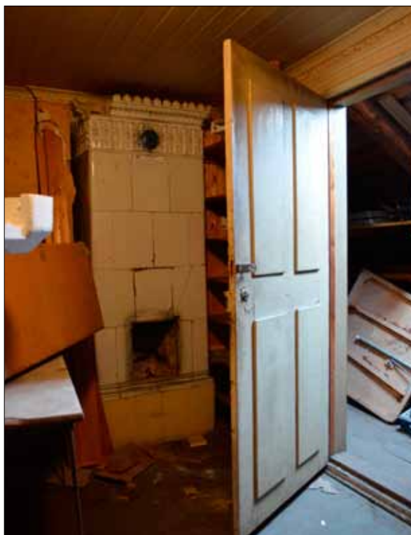
43 Bortre vindsrummet med flat kakelugn och äldre fyrfyllningsdörr (Slm D2014-307).
