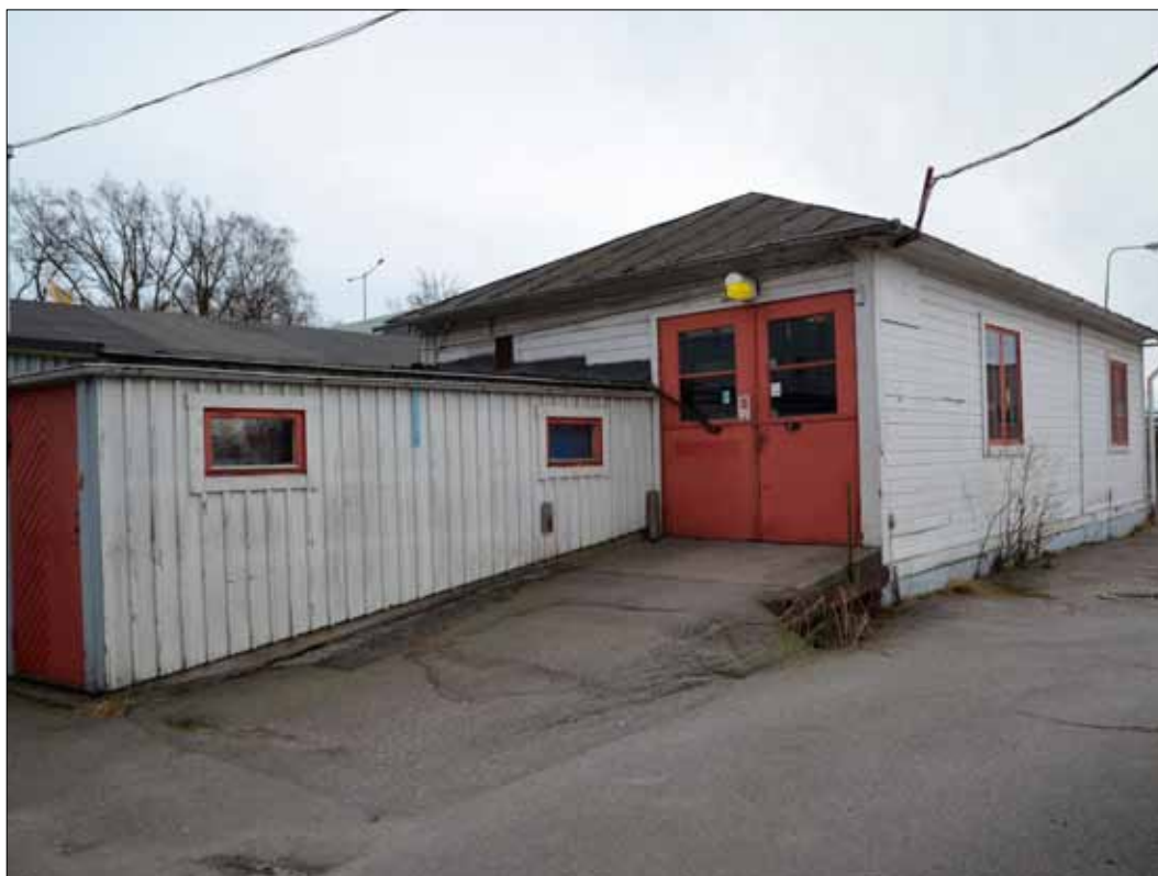
58 Hus 5 från nordost. I förgrunden tillbyggnaden som benämns 4c (Slm D2014-322).
