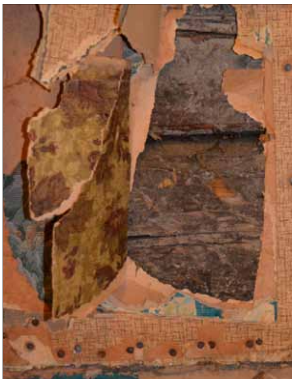
23 Tapetlager som syns i rum 102, samt upphugget timmer, troligen för lerklining (Slm D2014-287).
