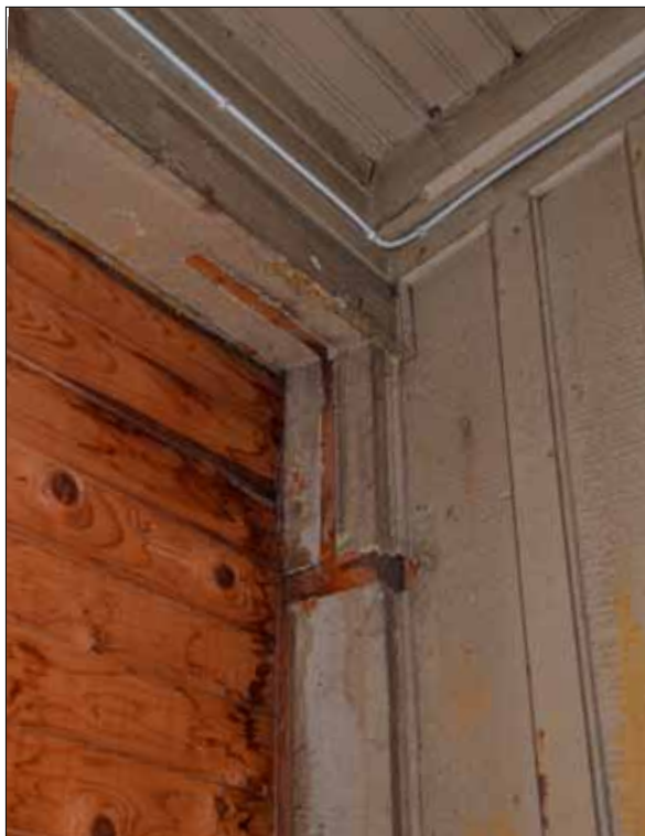
36 Detalj av fasad verandastolpe i rum 207. Notera den tidigare fasadpanelen (Slm D2014-300).
