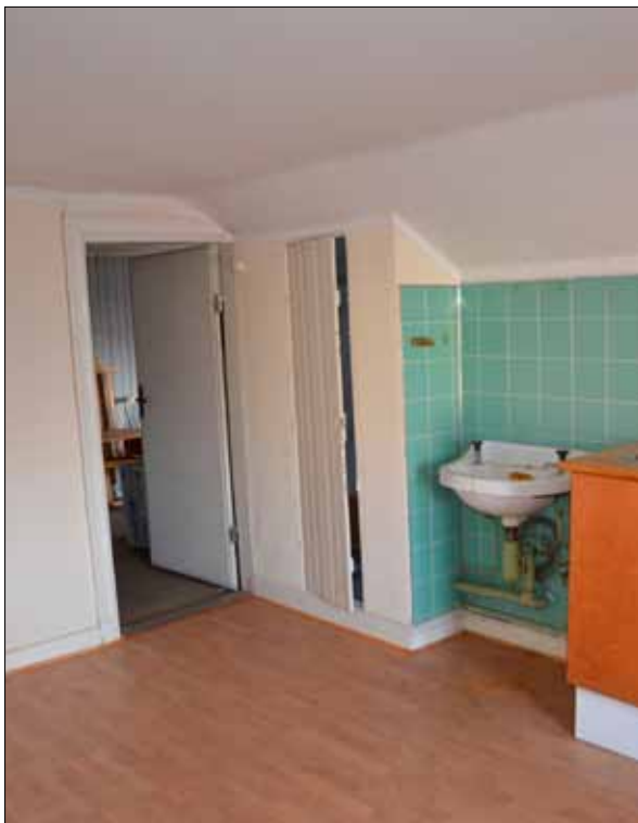
40 Första vindsrummet som ligger mot nordost (Slm D2014-304).
