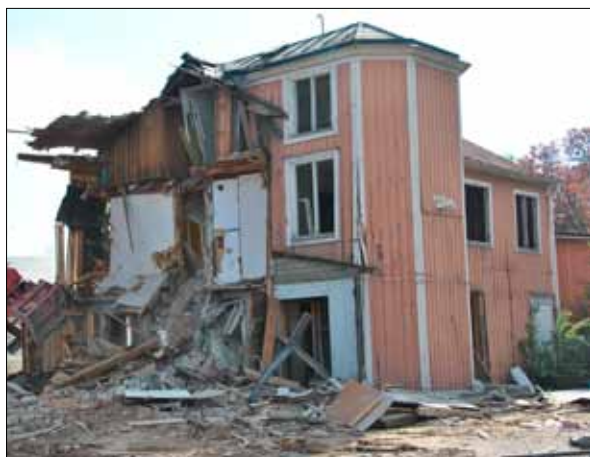
87 Rivningen av bostadshuset den 20 maj 2014 (Slm D2014-359).
