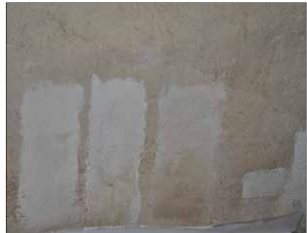
12 Provstrykningar i sakristian bredvid en framskrapad referensyta. Foto: Gabor Pasztor (Slm D2014-585).
