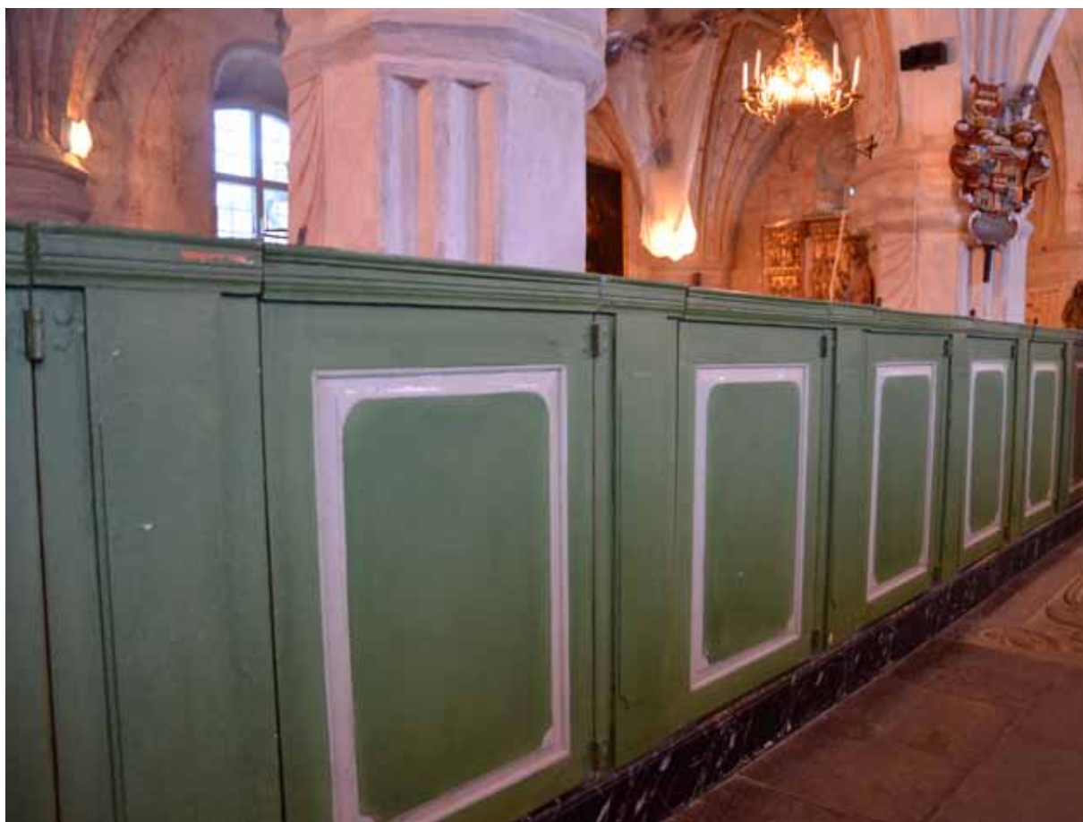
10 Bänkkvarterens dörrar före åtgärd. Krederingen har blivit synlig där färgen släppts (Slm D2014-583).
