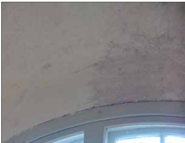
14 Fönsternischerna ljusades upp med kalkfärg. (Slm D2014-587).
