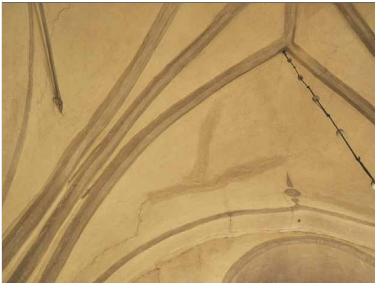
8 En av de södra valvkapporna före åtgärder. En större putsspricka samt en gammal väl synlig retuscherings (Slm D2014-581).
