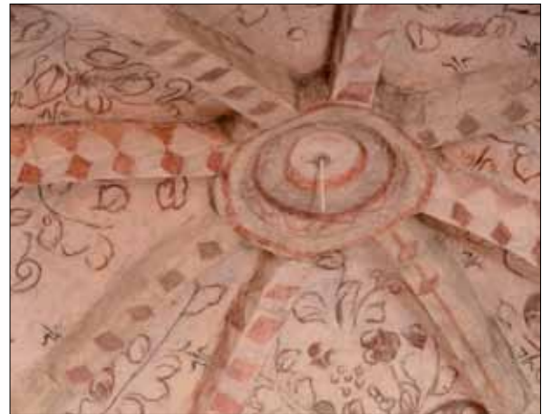
25 Rökrören kopplade till brandlarmsinstallationen är märkbart mindre synliga efter att valvens rengjorts. (Slm D2014-597).
