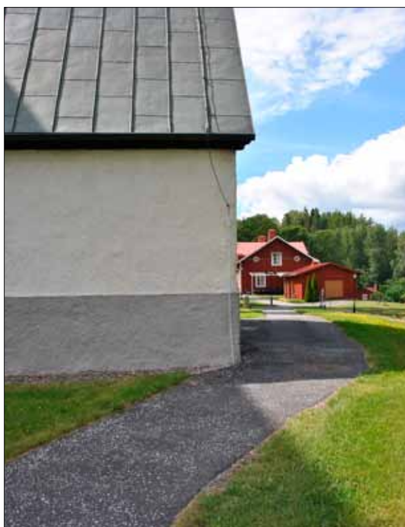
13 Samma gångparti efter asfalteringen (Slm D2014-403).
