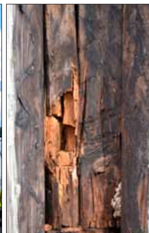
30 Kolonnens bas är rötangripen (Slm D2013-652).
