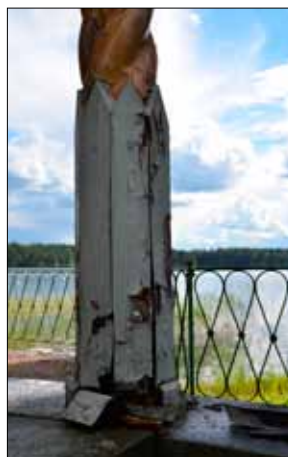
29 Den yttre kolonnen på höger sida är illa åtgången (Slm D2013-651).
