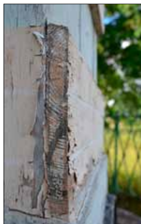
25 Färgskiktet har släppt från underlaget (Slm D2013-647).
