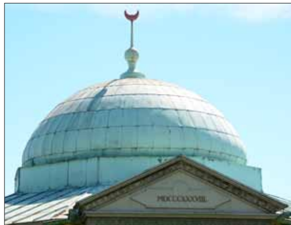
5 Paviljongens kupoltak med spira. I gavelns tympanonfält står byggnadsåret 1838 i romerska siffror. Foto Kjell Taawo (Slm D2013-632).
