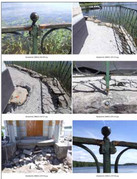
19 Blästring och målning av järnräcket. Två av portikens kolonner tas ned i samband med åtgärder kring trappan. Eva Wockatz (Slm D2013-642).
