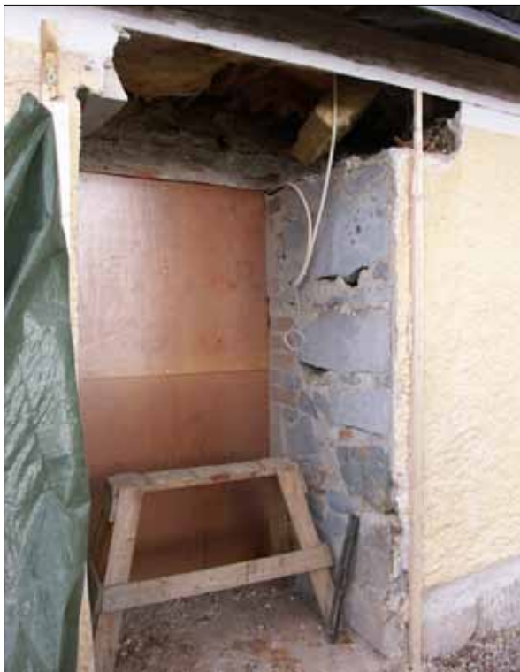
14 I sakristians västra vägg sågades en ny öppning upp (D12-0312).
