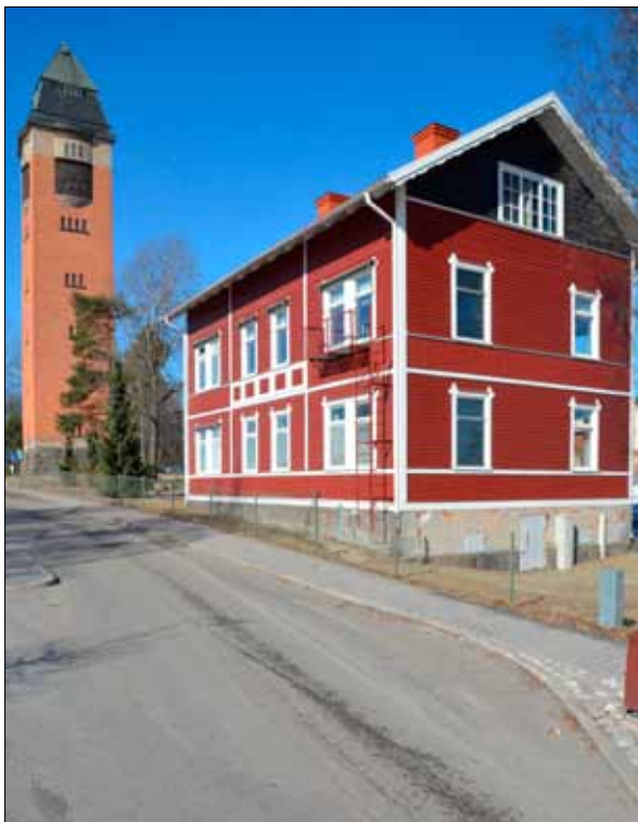
9 Fastigheten Tallen 5:3, stadens andra skola, samt gamla vattentornet (Sim D13-391).
