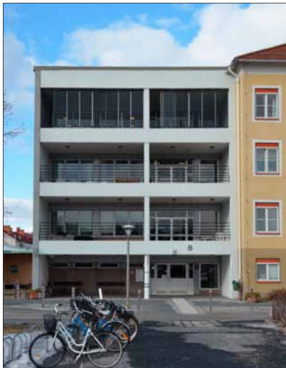
27 Fastigheten Blåduvan 4, Kullbergssjukhuset (Slm D13-407).
