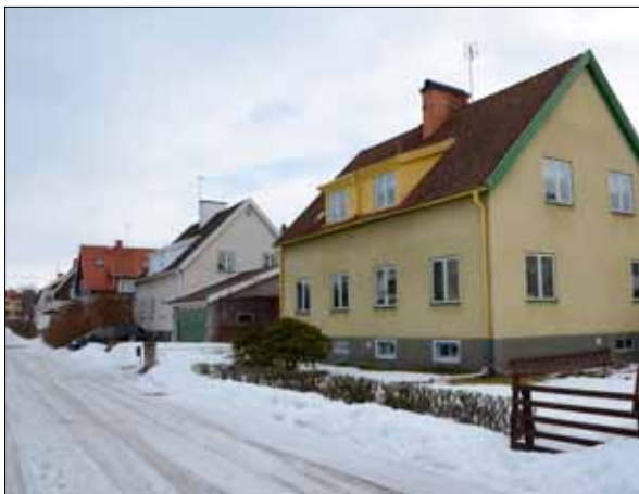
32 Fastigheten Fasanen 10 (Slm D13-411).
