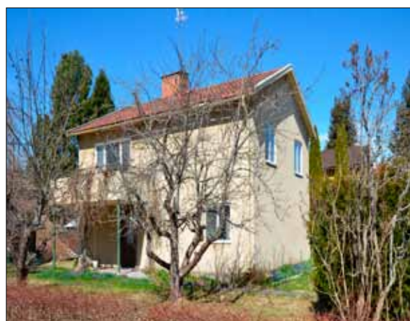
81 Välbevarad funkisvilla i fastigheten Stenkrossen 2 (Slm D13-451).
