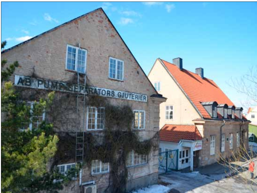
26 AB Pumpseparators byggnader vid Gjuterigatan. Miljön och byggnaderna är kulturhistoriskt värdefulla (Slm D13-406).
