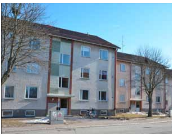
15 Fastigheten kv. Grenen 3 och 4, uppförda för Karsuddens personal 1963 (Slm D13-396).
