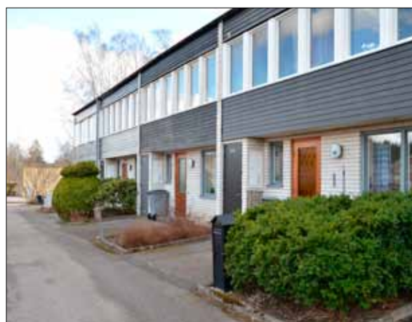
91 Radhus i fastigheten Kontoristen (Slm D13-460).
