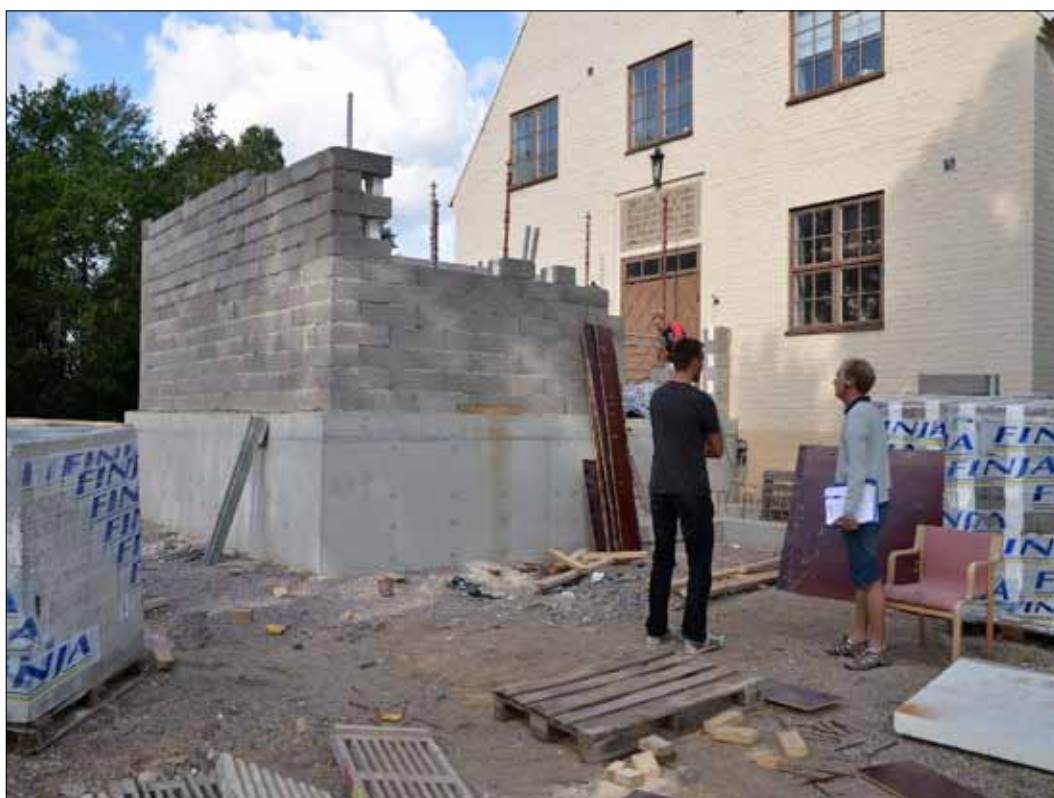
9 Fasadernas stommar uppmurades av Lecablock (Slm D13-0068).
