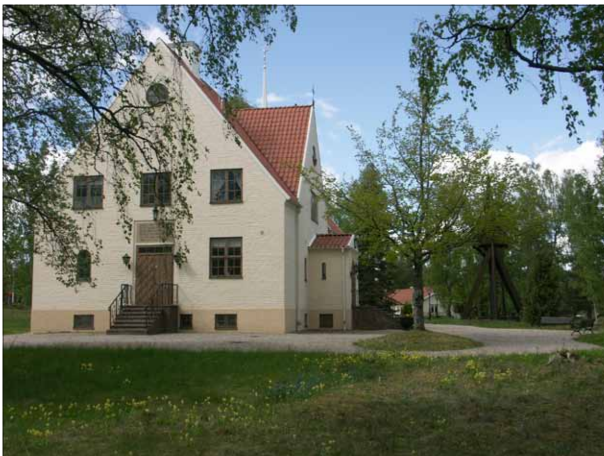
7 Hällby kyrka från söder innan tillbyggnaden uppfördes (Slm D13-0066).
