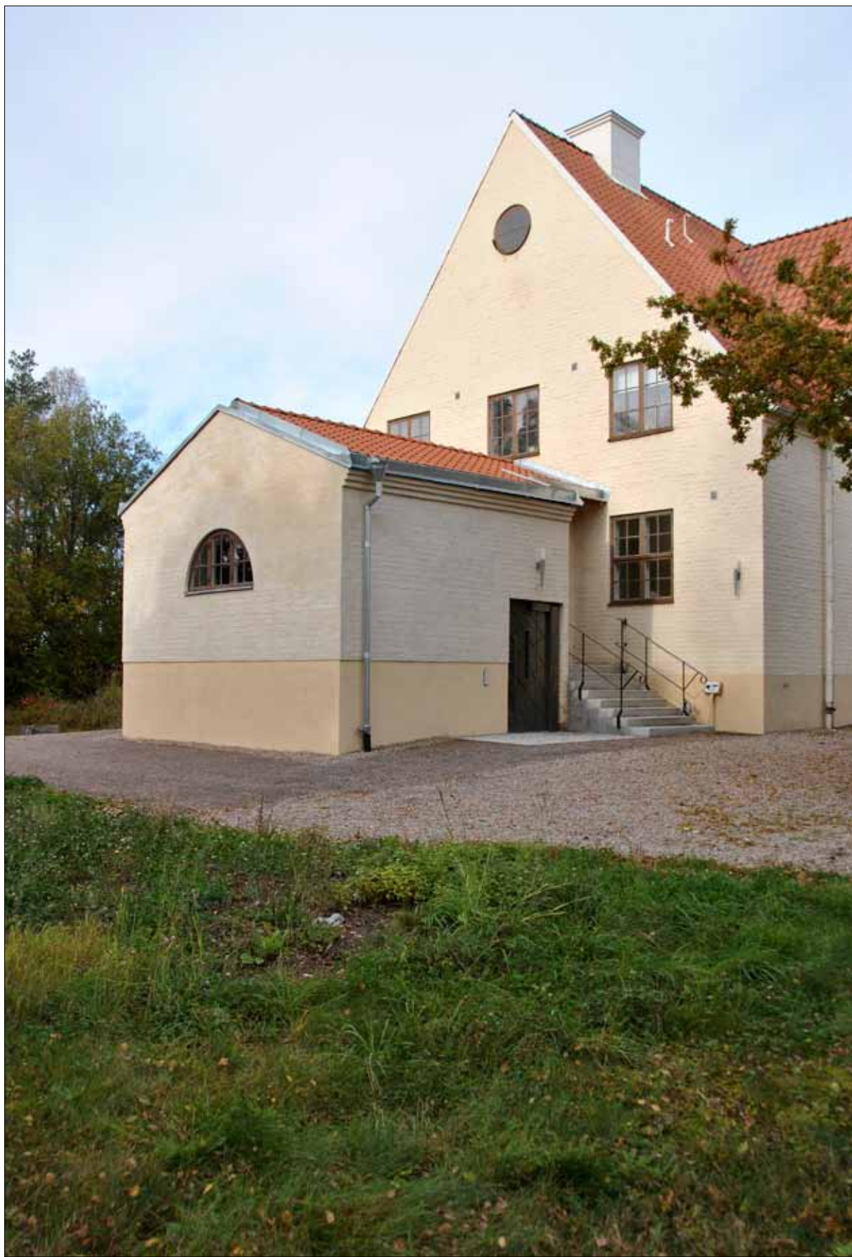
31 Tillbyggnaden från sydost (Slm D13-0090).
