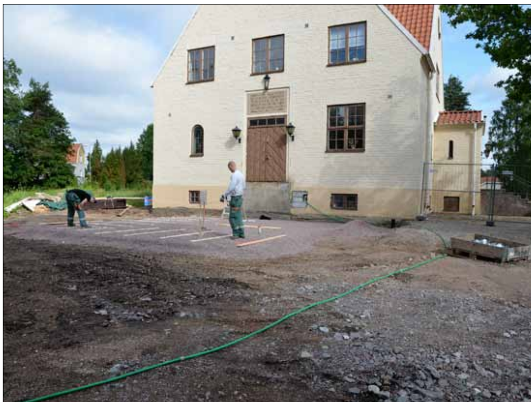
8 Förberedelser för gjutning av tillbyggnadens grund i juni 2011 (Slm D13-0067).
