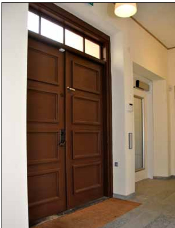
13 Den flyttade porten och hissdörren i entréhallen (Slm D13-0072).
