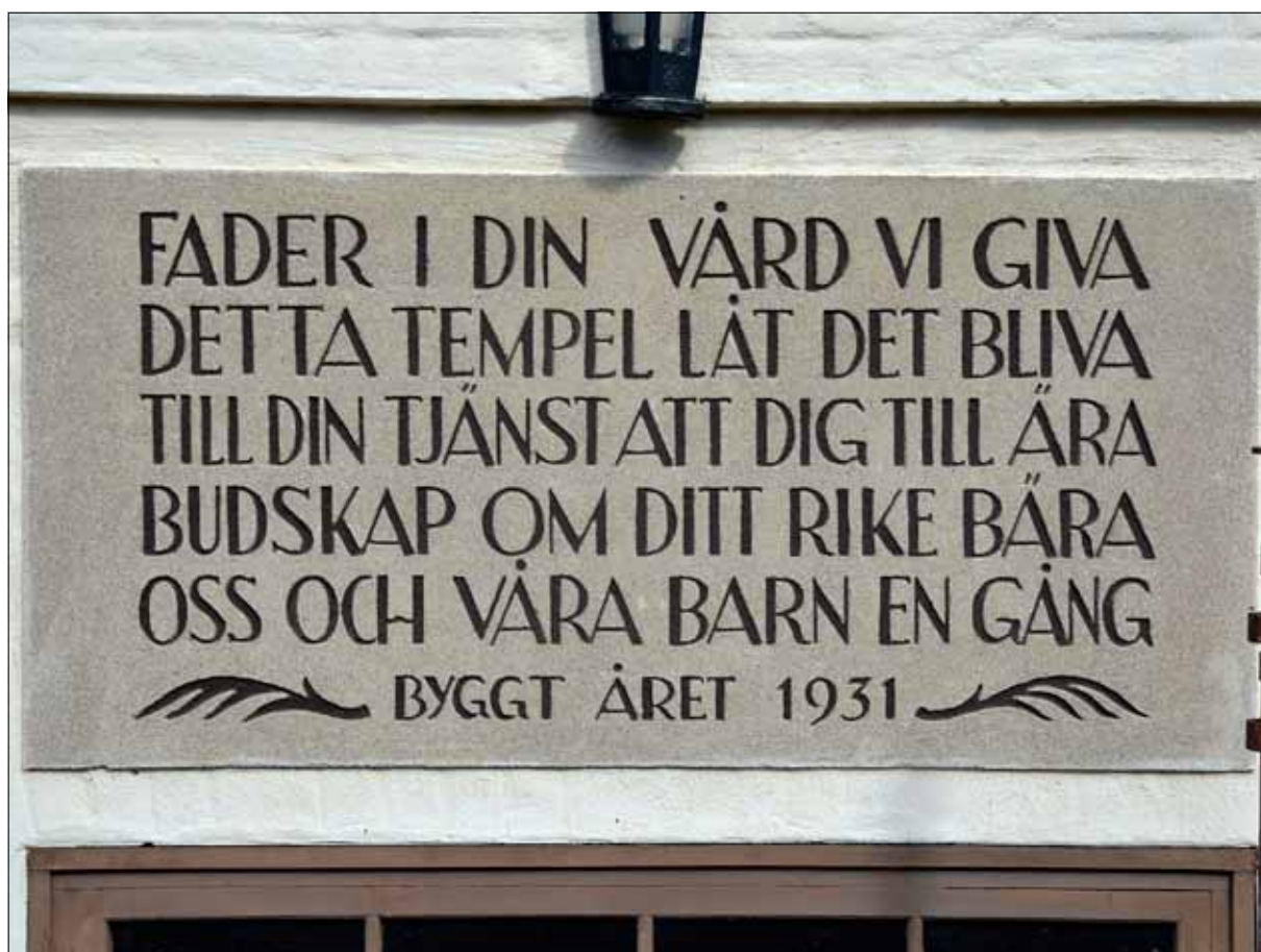
28 Inskriptionstavlan visade sig vara utförd i putsbruk och kunde därför inte tas ned för att ges en ny placering (Slm D13-0087).
