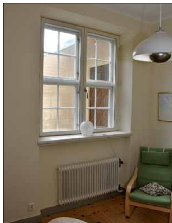
26 Fönstret i förberedelserummet har försetts med en ny inre fönsterbåge med brandskyddsglas (Slm D13-0085).
