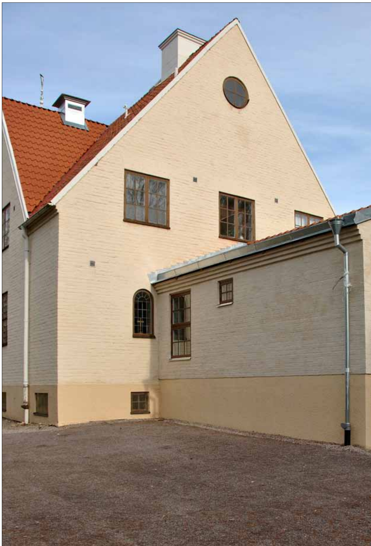
27 Tillbyggnadens möte med kyrkans södra gavelfasad från sydväst. På bilden ses även den nya ventilations- huvn på taknocken till kyrkans västra frontespis (Slm D13-0086).
