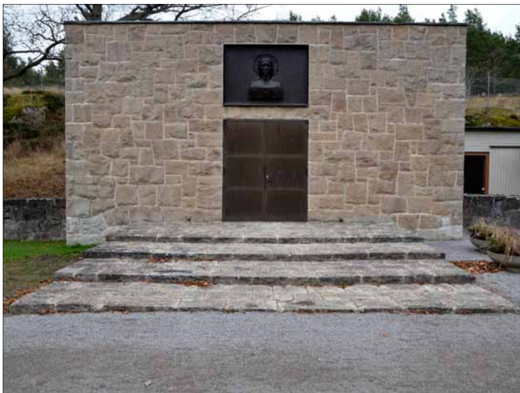
11 Entrétrappan efter avslutat arbete (Slm D13-0122).
