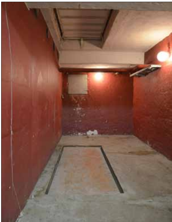
16 Kisthissen och luckan till kryputrymmet öster om källaren innan arbetet påbörjades (Slm D13-0127).
