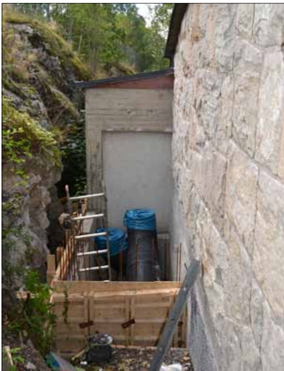
8 Gjutningen av tillbyggnadens stomme i september 2012 (Slm D13-0119).
