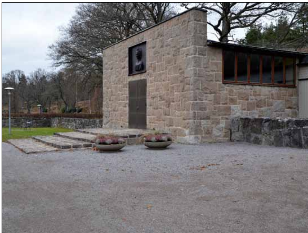
5 Frösängs kapell från sydväst efter avslutad utvändig renovering (Slm D13-0116).
