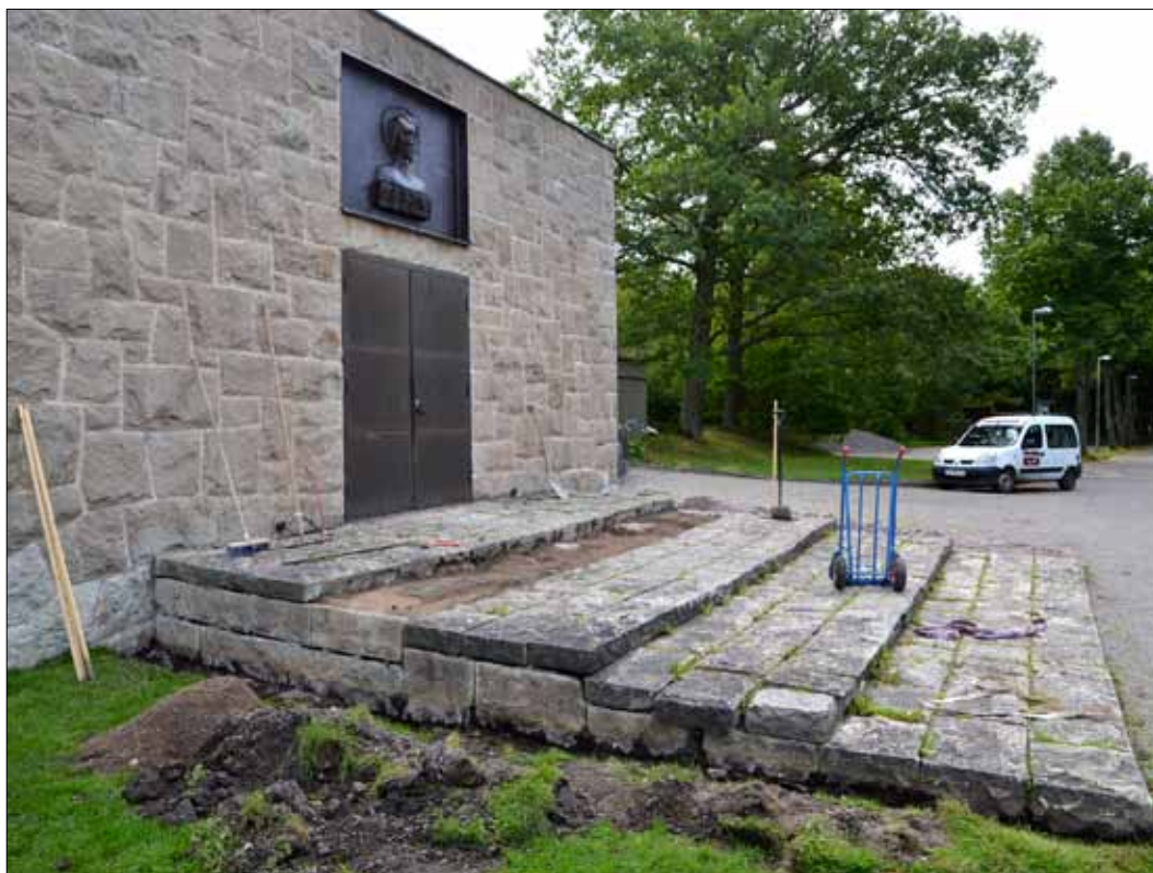
10 När stenarna i det översta trappsteget demonterades konstaterades att trappans grundläggning var i bättre skick än förväntat (Slm D13-0121).
