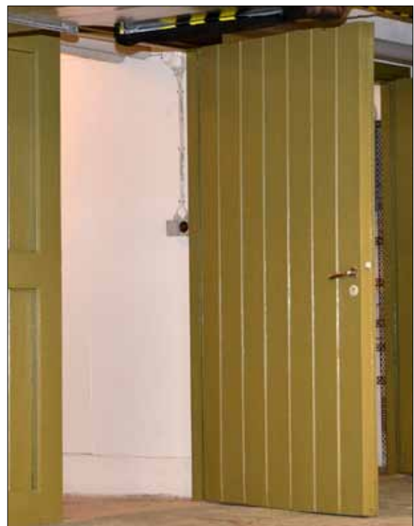
20 Samma dörröppning efter avslutad målning (Slm D13-0131).
