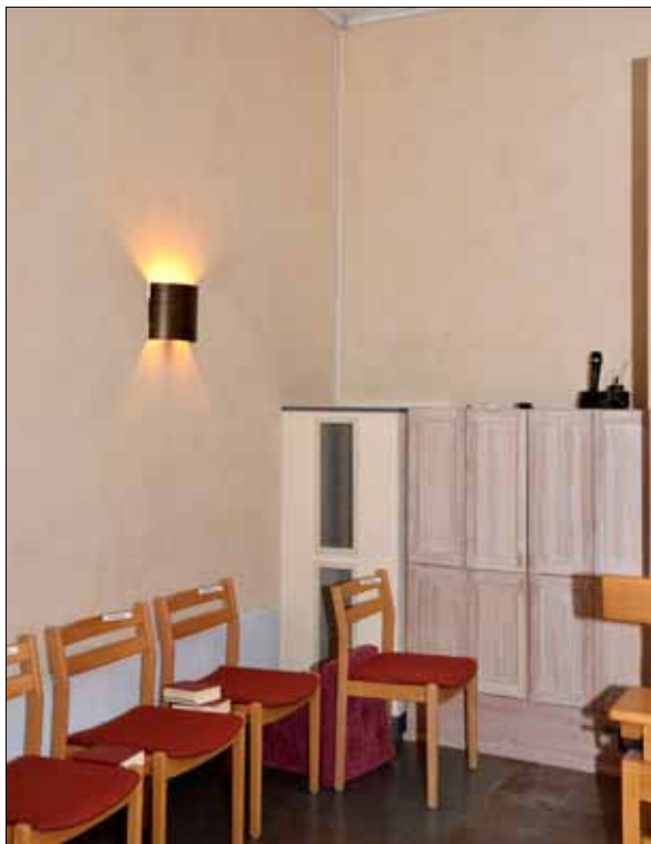
26 Frånluftsdonet intill orgeln i rummets nordvästra hörn. Till vänster i bild ses en av de nya vägg-lampetterna (Slm D13-0137)
