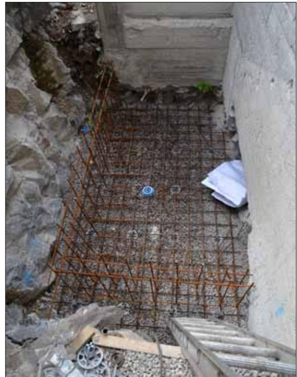
7 Arbeta med gjutformen för tillbyggnaden i augusti 2012 (Slm D13-0118).
