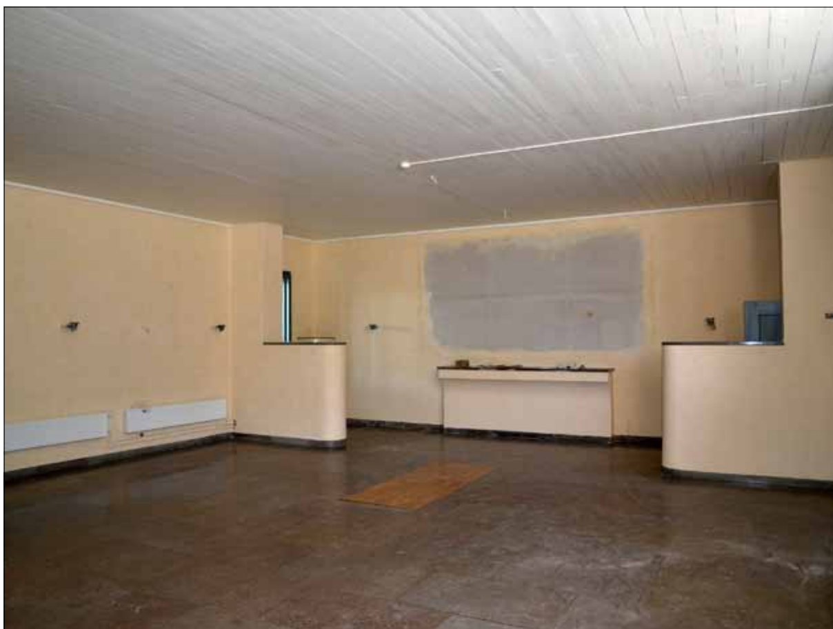
31 I samband med Rolf Berghs restaurering av kapellet 1972-73 gråmålades väggarna i ceremonirummet med linoljefärg. I samband med nu slutförda arbeten sparades denna yta bakom altarmålningen (Slm D13-0142).
