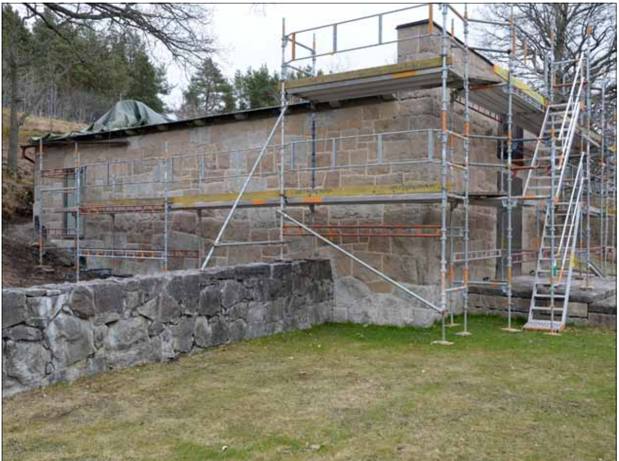
12 Omfogningen av kapellets fasader utfördes i april 2012 (Slm D13-0123).
