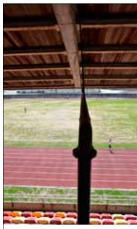
41 Vattenavledningsrören bör efterlikna de främre originalstuprören i form och proportioner. Foto: Eva Wockatz (Slm D13-509) (Slm D13-515).
