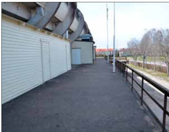
26 På norra fasaden finns idag utskjutande förråd, en del av förråden är sannolikt tillkomna senare (Slm D13-494).
