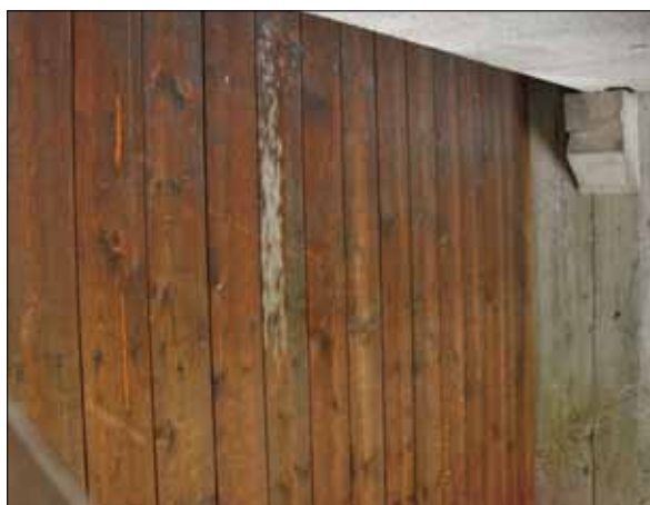
42 Under läktargradängerna finns välbevarade fält av panel som sannolikt har kvar sin originalfärgsättning. Fälten skulle kunna användas som referensramar till övrig innertak- och fasadpanel. (Slm D13-516).
