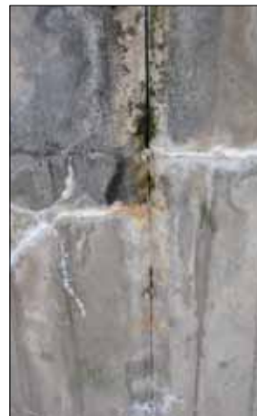
32 Läktargradängernas skruvgenomföringar har på många håll roststat och sprängt sönder betongen. (Slm D13-506).
