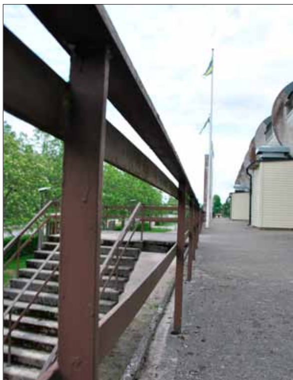
29 Detalj av räcket på läktarens baksida (Slm D13-497).
