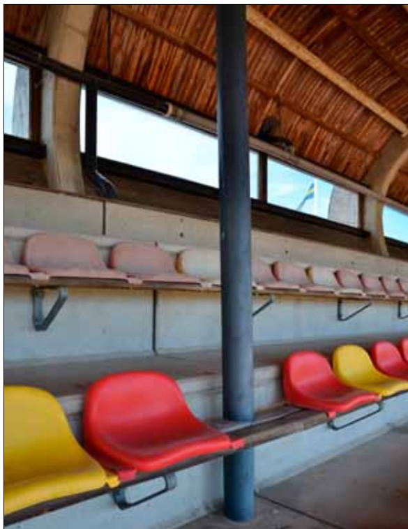
44 Somliga av sittplatsstolarna i plast har blekts eller spruckit sönder. Foto: Eva Wockatz (Slm D13-518)
