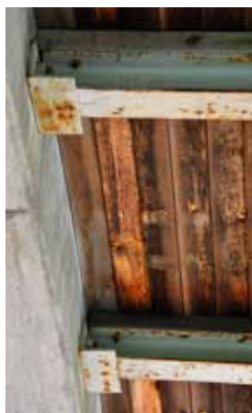
9 Detalj av balkarna som bär upp taket och som vilar på stålklackar (Slm D13-484).
