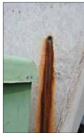
34 Vattenläckage från hängrännan längst upp på läktaren (Slm D13-508).
