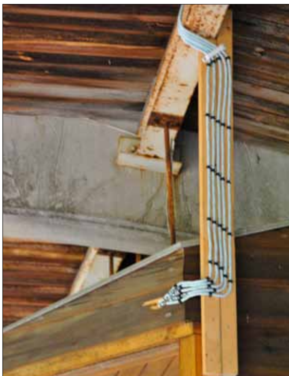
46 Ovarsam kabeldragning (Slm D13-520)
