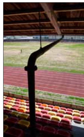
41 Vattenavledningsrören bör efterlikna de främre originalstuprören i form och proportioner. Foto: Eva Wockatz (Slm D13-509) (Slm D13-515).
