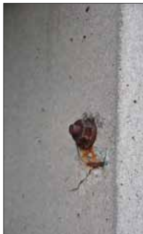
32 Läktargradängernas skruvgenomföringar har på många håll roststat och sprängt sönder betongen. (Slm D13-506).
