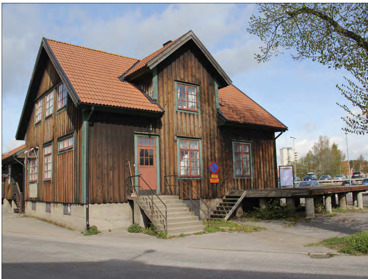
40 Godsmagasinet's östra del byggdes 1918. Här låg expeditiionslokalerna. På övervåningen fanns övernattningsrum för sovvagnskonduktörerna, idag bostadslägenheter (Slm D12-0451).
