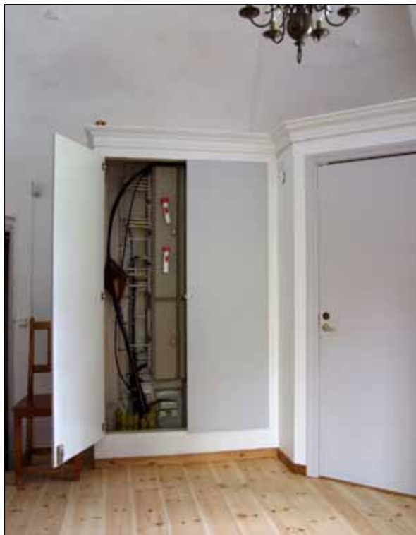
29 Sakristians el-central har byggts in ett väggfast skåp (Slm D11-198).
