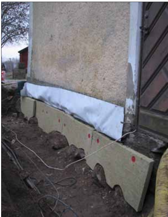
16 Markisoleringskivor och täckande duk monterade på sakristians norra fasad (Slm D11-185).
