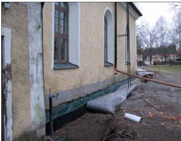
3 Långhusets norra fasad i samband med återställning av mark efter montering av nya tätskikt och markisolering (Slm D11-172).
