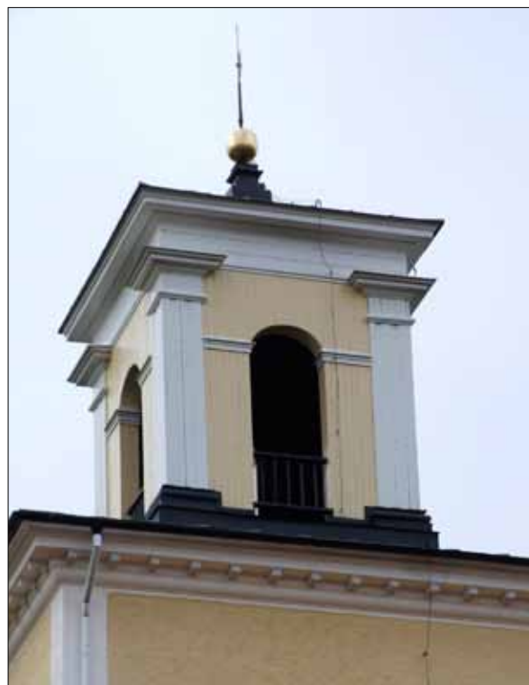
6 Tornlanterninen efter avslutade arbeten i oktober 2009 (Slm D11-175).
