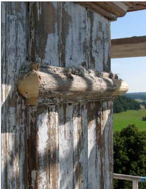
20 Kompletterande trälagningar på ett av lanterninens kapitäl. Foto: Karl Anderberg, Sörmlands museum (Slm D11-189).
