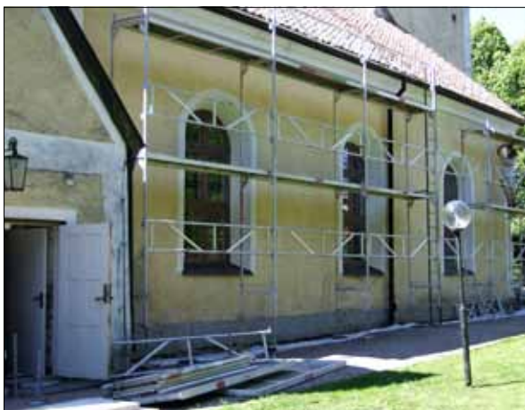
4 Pågående ställningsbyggande på kyrkans norra sida i samband med startmötet den 22 juni 2009 (Slm D11-173).
