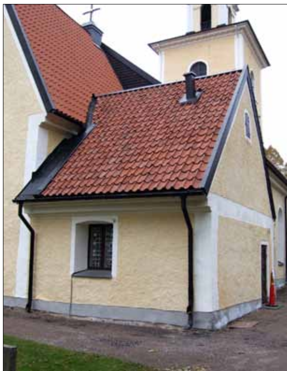
25 Sakristians takfall täcktes med befintligt tegel. Övriga takfall med nytt tegel från Vittinge tegelbruk (Slm D11-194).
