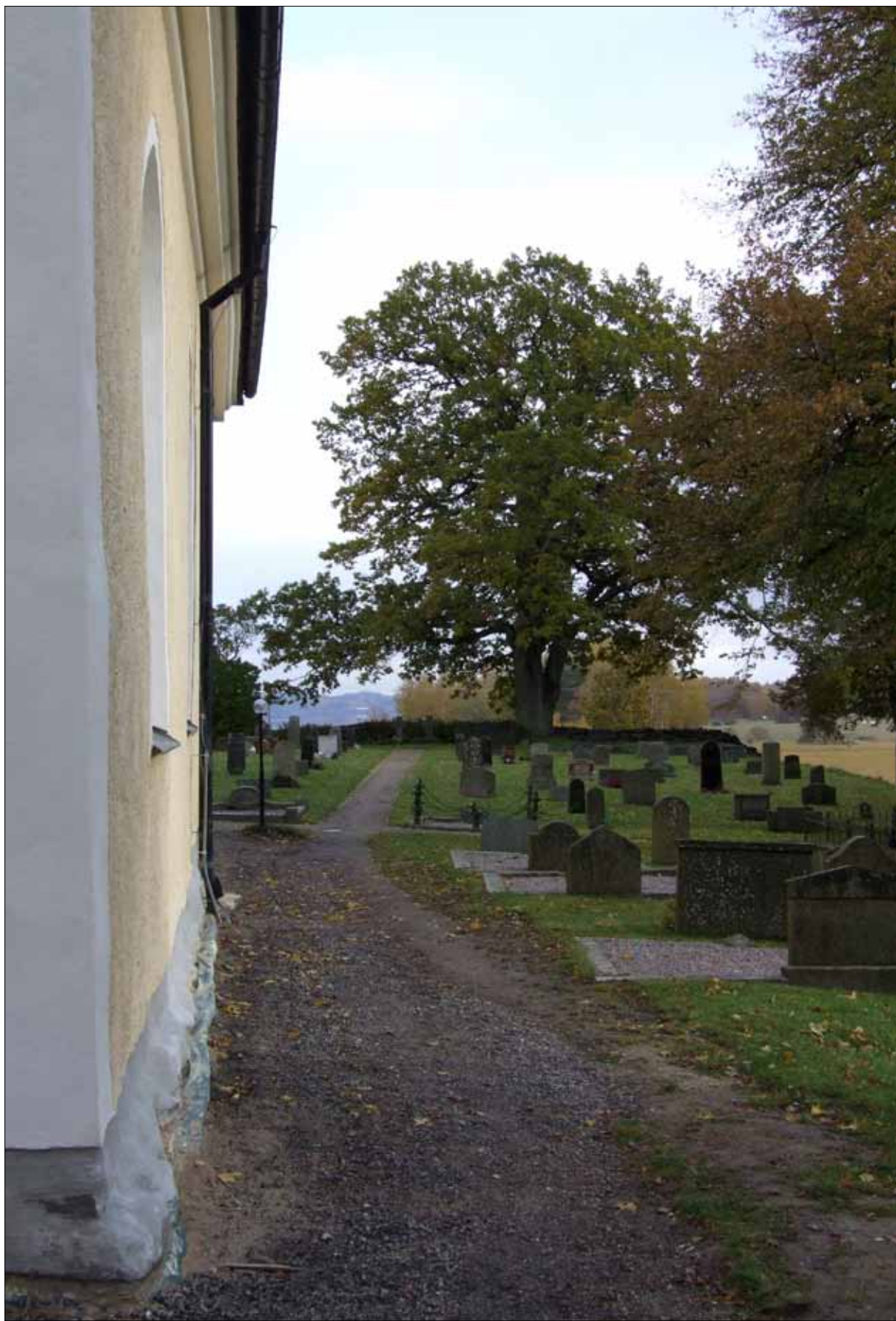
32 Långhusets södra fasad (Slm D11-201).
