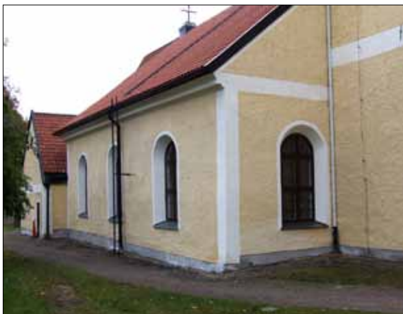
5 Kyrkans norra sida efter avslutade arbeten i oktober 2009 (Slm D11-174).
