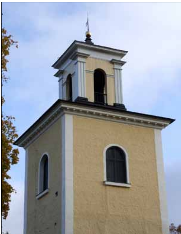
21 Lanterninens nya färgsättning framhäver dess arkitektoniska uppbyggnad (Slm D11-190).
