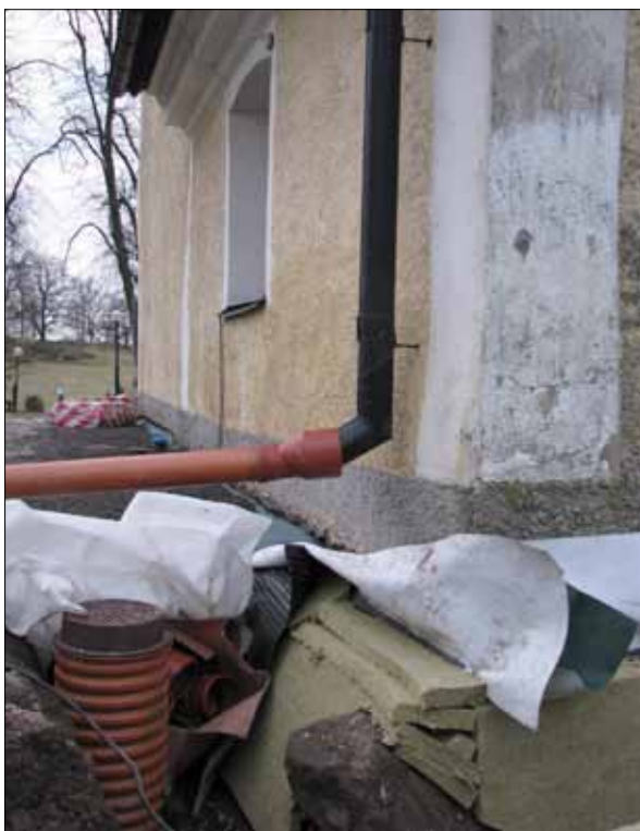
17 Pågående återställning vid sakristians nordöstra hörn (Slm D11-186).
