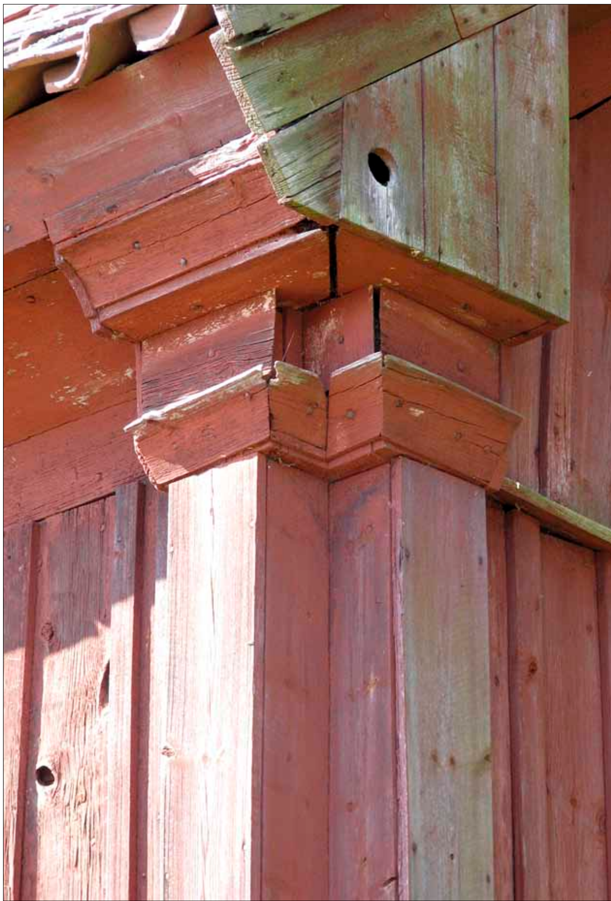
66 Detalj av knutkedjans inklädnad på manbyggnadens nordöstra hörn (Slm D10-569).
