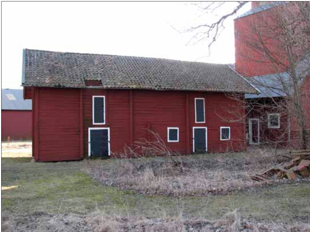
57 Magasinet vid Brunsta gård, hus 3 från nordost (Slm D10-560).
