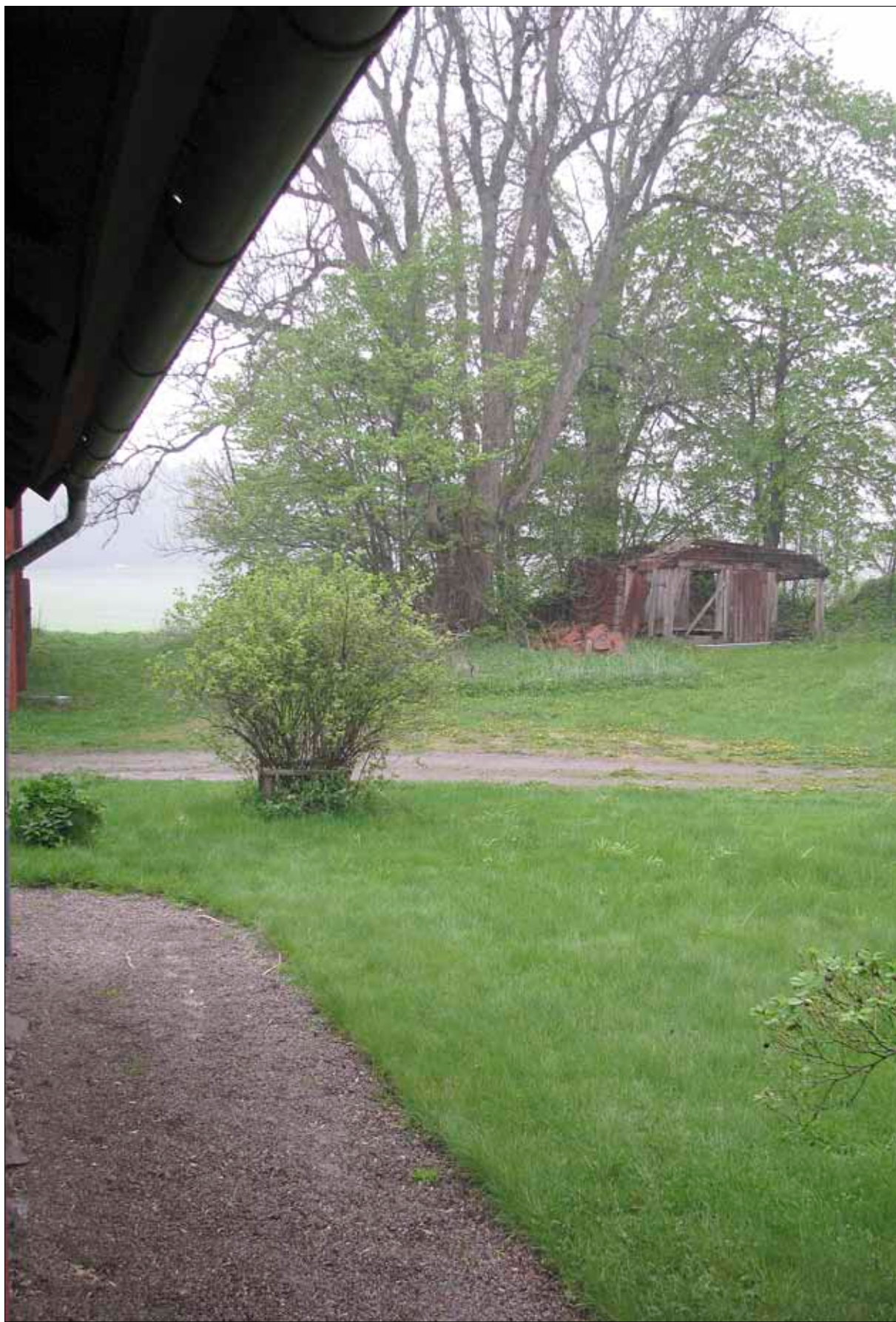
64 Jordkällaren har sedan länge förlorat sin funktion på grund av eftersatt underhåll (Slm D10-567).
