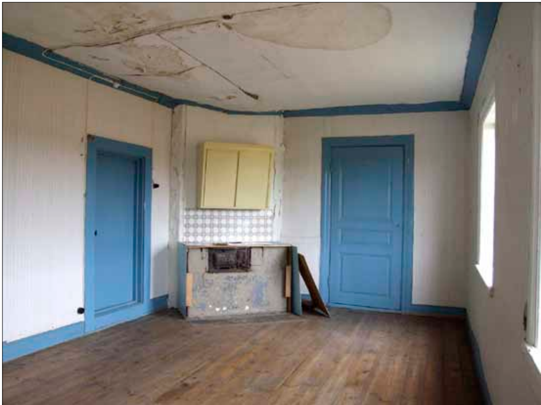
42 Rum 110 från sydost (Slm D10-545).
