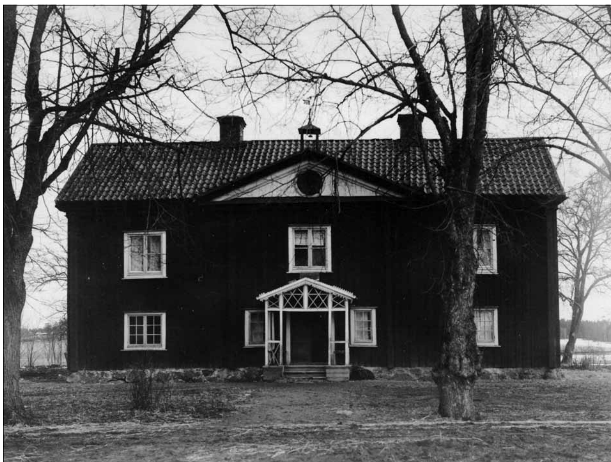
14 Manbyggnaden, hus 1, från öster. Foto Ivar Schnell 1936 (Slm M012996).
