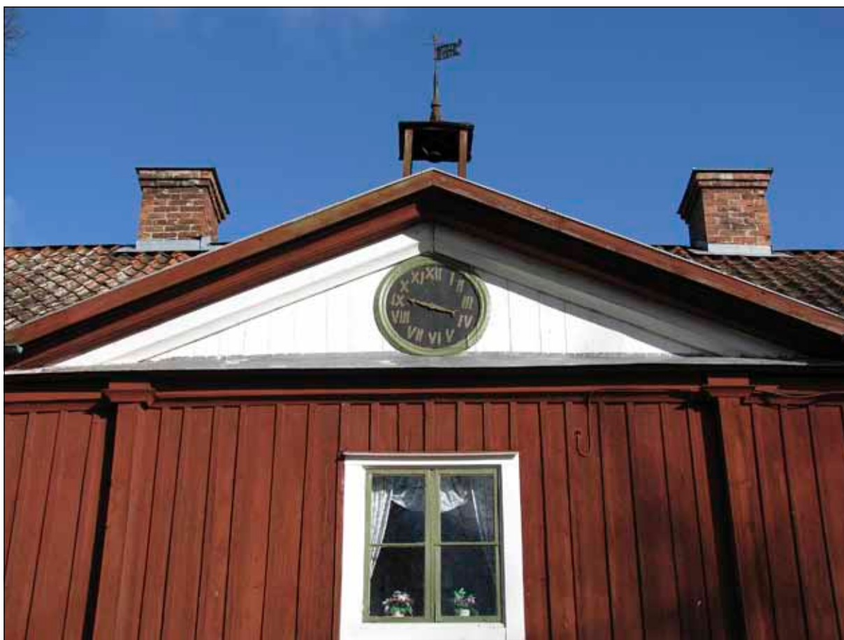
13 Manbyggnadens huvudfasad mot väster (Slm D10-517).
