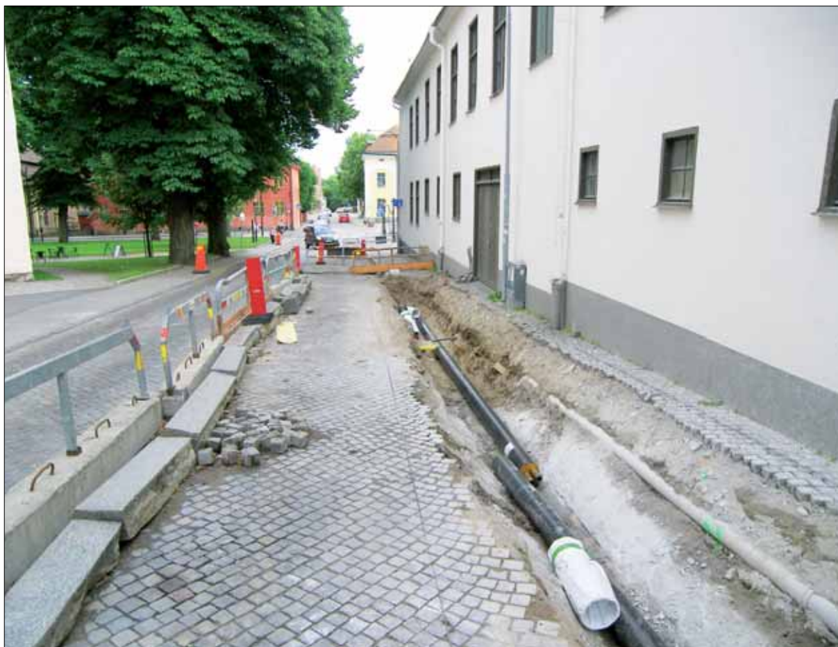
Figur 3. Södra delen av det färdiga fjärrvärmeschaktet fick delvis huggas ned i en 0,9 meter djup ränna i berget (se bildens främre del). Schaktet fotograferat från norr. Foto: Björn Pettersson 2013, Sörmlands museum.
