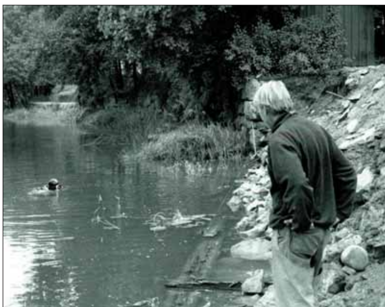
Figur 5. Dykare i vattnet utanför kajen vid Hamnbron, i färd med att undersöka bottenförhållandena i samband med schaktningar i vattnet. Observera den frilagda rustbädden av timmer i vattnenlinjen. På grund av strandlinjeförskjutningen sedan kajen anlades i början av 1900-talet, har timret börjat förmultna. Därav sättningsskadorna i kajmuren. Foto: Björn Pettersson 2002, Sörmlands museum.
