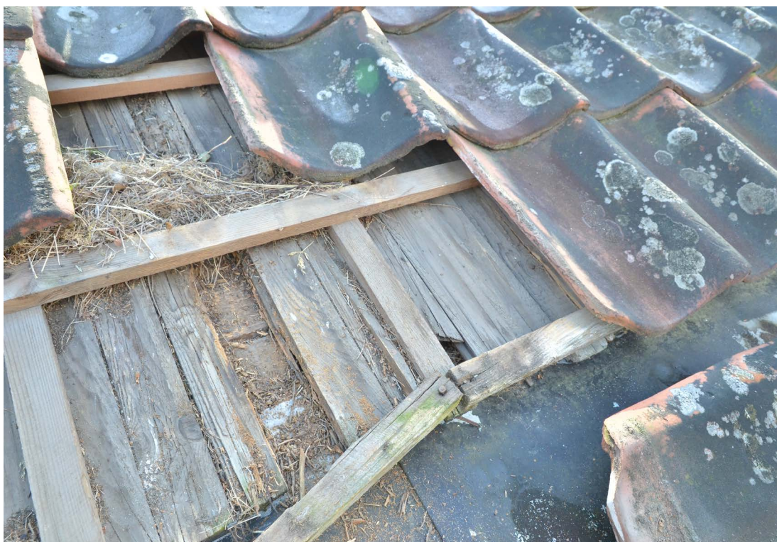
Bild 16. Detalj av norra takfallets nedre del. Bara en liten del av fotrännans plåt var "uppdagna" under det senare underlagstaket. Teglet låg på strö- och bärläkt. Före renovering. (SLM D2022-0863).
