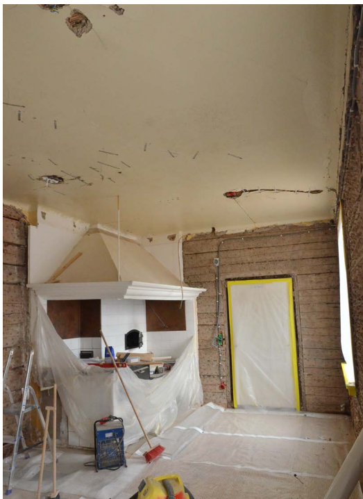
Bild 40. Del av köket efter det att väggputs och sentida undertak av träpanel tagits bort. Under det senare undertaket fanns det putsade innertaket kvar, som behölls. (SLM D2022-0884).
