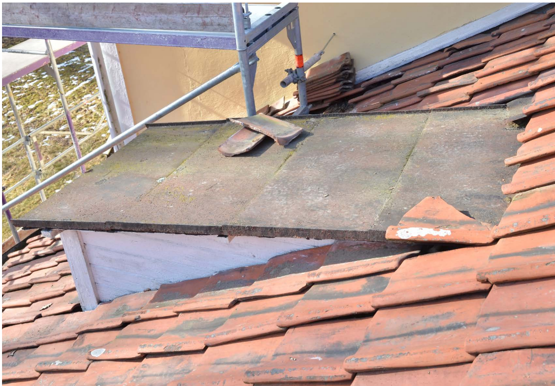
Bild 25. Den äldre takkupan på södra takfallet var täckt med äldre järnplåt. (SLM D2022-0871).
