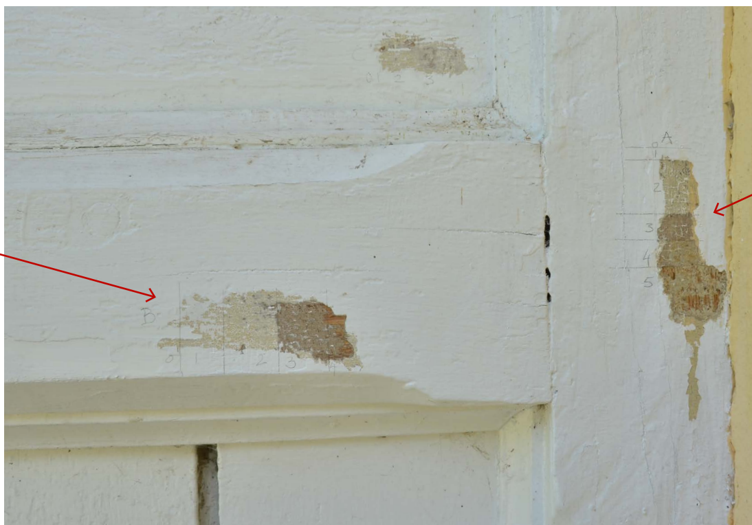
15. Färgskikt på södra verandan. Till höger stolpen och till vänster den liggande tvärsån. Olika sorters umbror syns under de vita nuvarande färglagren. (SLM D2021-0862).
