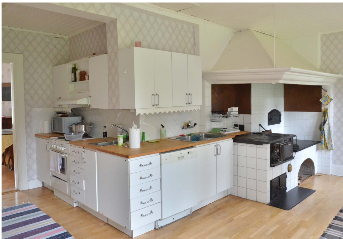
Bild 42. Del av köket före vattenläckan och före renoveringen. Taket och väggarna är putsade, men har senare kläts med moderna ytskikt. På golvet ligger ett sentida parkettgolv (SLMD2022-0886).
