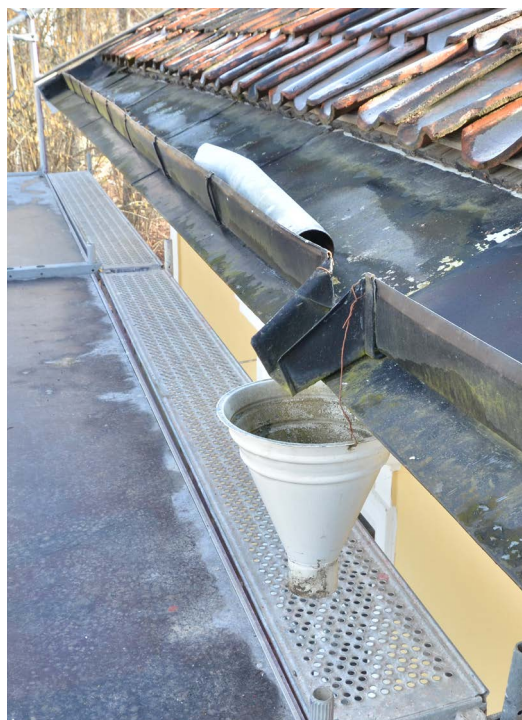
Bild 18. Del av norra fasadens fotränna med smidda rännkrokar och utkastare. (SLM D2022-0865).
