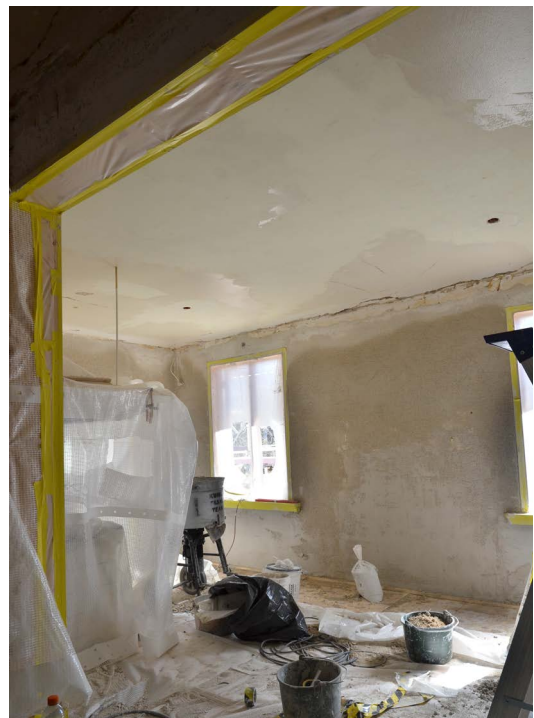
Bild 41. Kökets väggar putsades om. (SLM D2022-0885).
