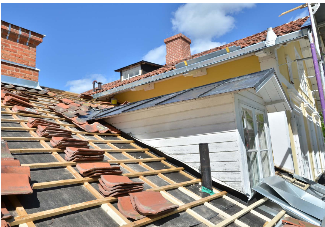
Bild 26. Ny underlagsduk har lagts på takfallen, samt ny strö-och bärläkt. (SLM D2022-0872).
