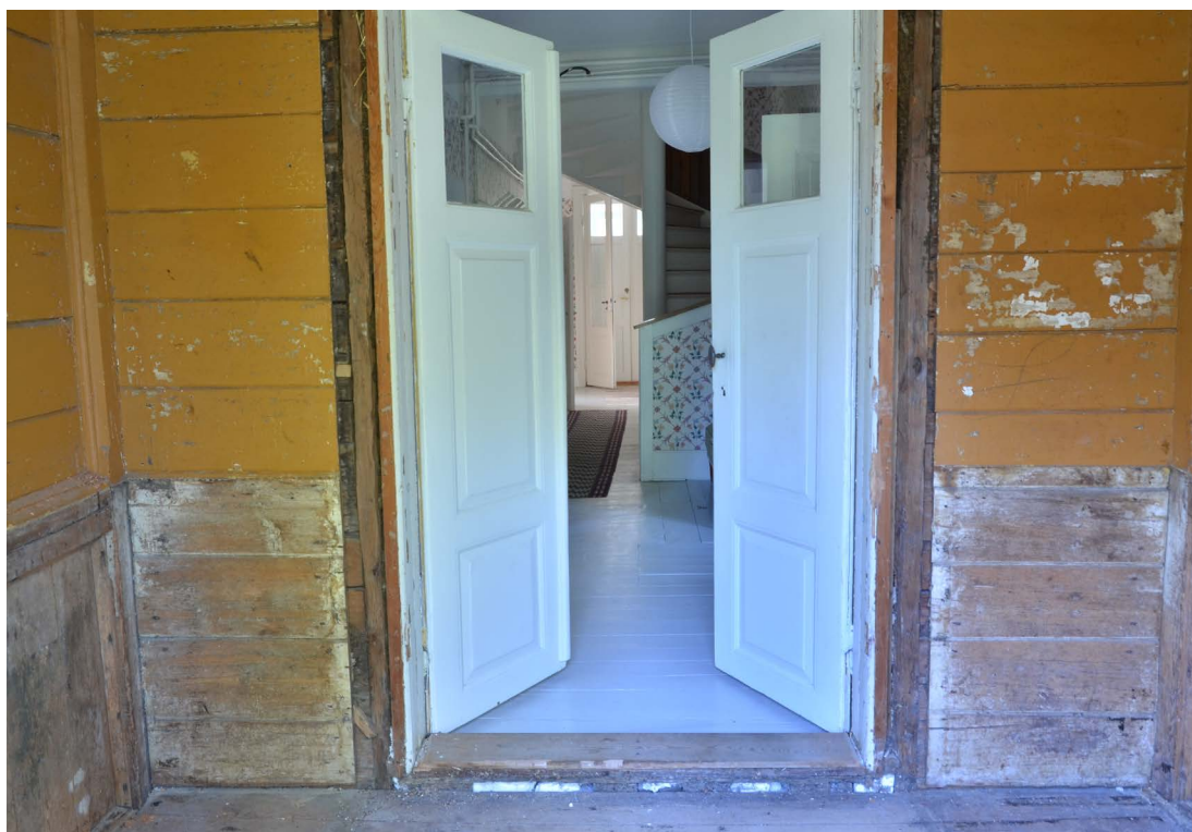
Bild 33. Södra verandans insida sedd mot den inre äldre glasade pardörren som togs bort. Pardörren ersattes med nytillverkade isolerade dörrar. På väggarna och golvet syns spår av vedlårar (SLM 2022-0877).
