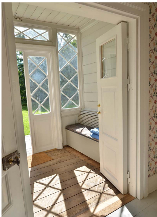
Bild 32. Vy av södra verandans interiör efter arbeten. Nya vedlådor med fast fällbänk har byggts på varje sida (SLM D2022-0876).
