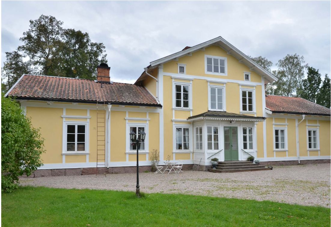
Bild 8. Före detta skolbyggnadens entrésida i september 2020. Vy från nordost före renoveringen. (SLM D2020-0625).
