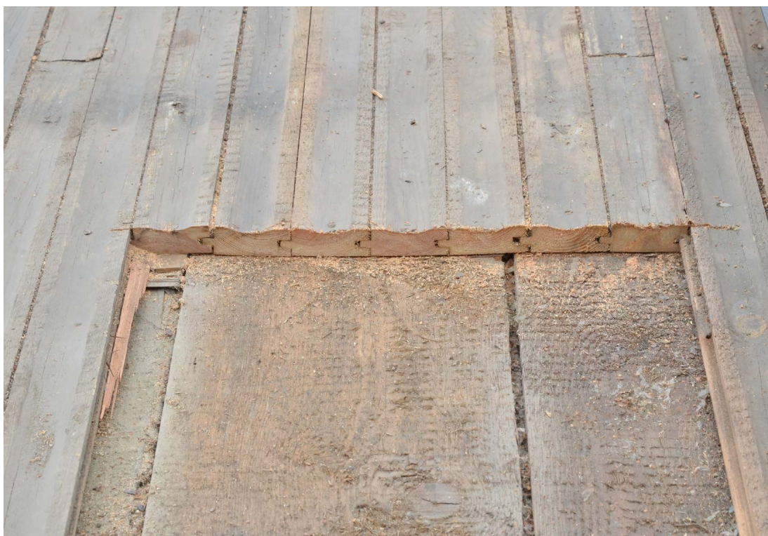
Bild 20. Detalj av underlagstaken. Underst syns det äldre ramsågade underlagstaket. Ovanpå ligger ett senare underlagstak, med smala, spontade och kupade brädor (SLMD2022-0867).
