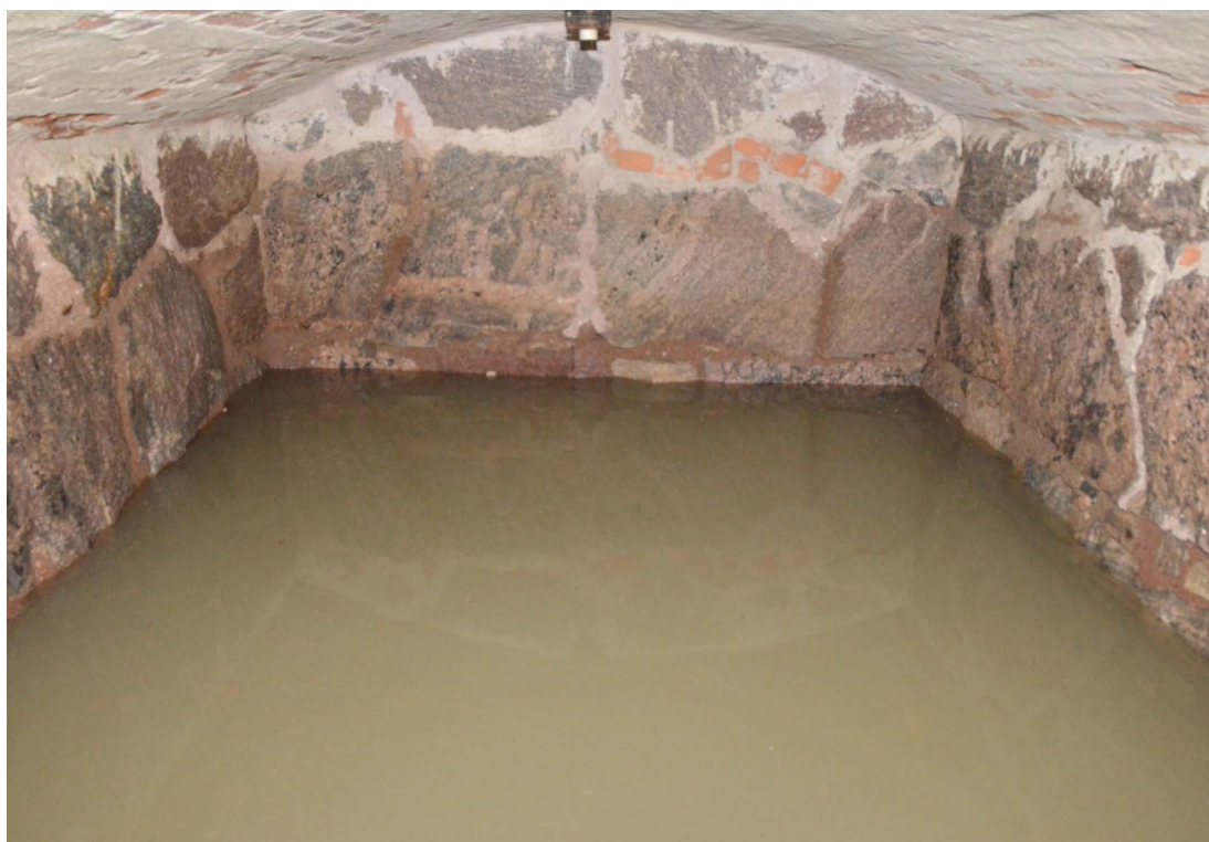
Bild 49. Bild av kökets underliggande jordkällare, som nås via en lucka i golvet, intill köket. Den 4 september 2023. (SLM D2023-0556).
