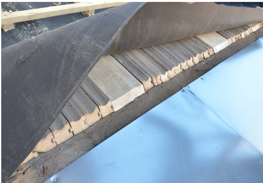
Bild 23. För att kunna montera fotrännans takplåt högre upp, så fasades underlagstaketets nedre del. Ytterligare en plåt lades sedan över underlagstaket och plåten, med underlagsduken ovanpå. (SLM D2022-0870)
