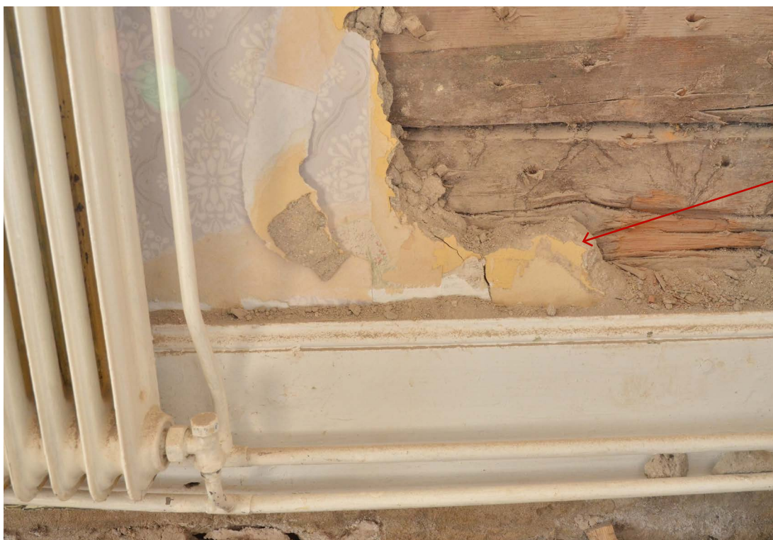
Bild 46. Detalj av väggputs, lerputs, på kökets södra vägg. Putsen var underst målad i en ljus brun kulör. (SLM D2022-0890).
