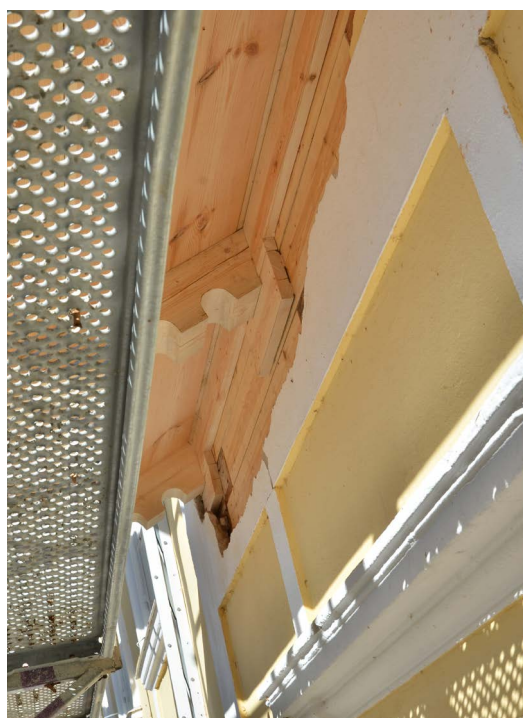
Bild 22. Efter reparation av takstolstassar och delar av ytterväggens timmer. Södra fasadens östra del. (SLM D2022-0869).
