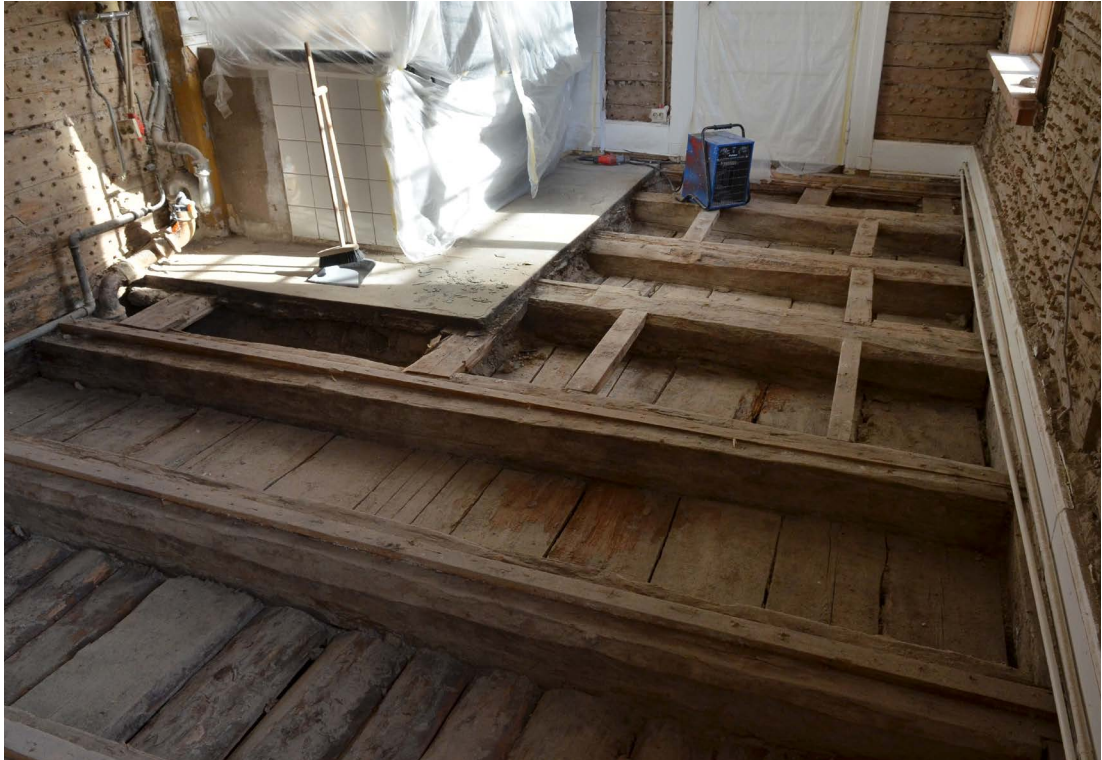
Bild 39. Bjälklaget i köket (rum 1:6) efter det att fuktig isolering i bjälklaget tagits bort efter vattenläckan. På blindbotten lades ny lösullsisolering av stenull. (SLM D2022-0883)
