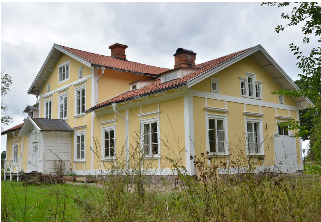
Bild 9. Före detta skolbyggnaden sedd från sydost före renoveringen. Östra gaveln har ett tredelat fönster och en port till det senare byggda garaget (SLM D2020-0626).
