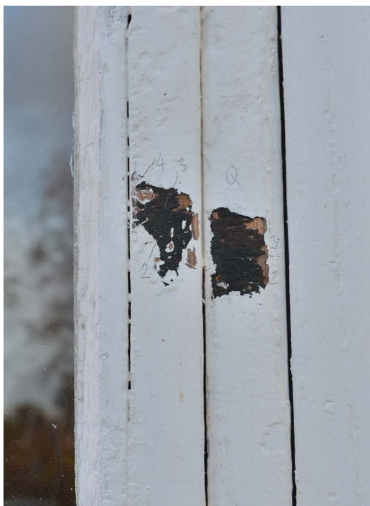
13. Fönsterbågarna har tidigare varit målade mörkt gröna, och före det mörkbruna. Även en ljus gröngrå nyans syns underst. (SLM D2021-0860).
