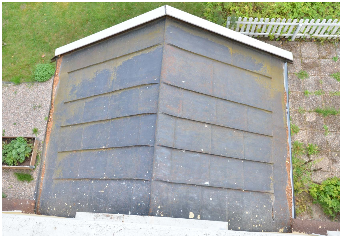
Bild 45. Södra verandans yttertak av äldre järnplåt sett uppifrån, före det att plåten byttes ut. Notera utkastarna i de yttre hörnen. (SLM D2022-0889).
