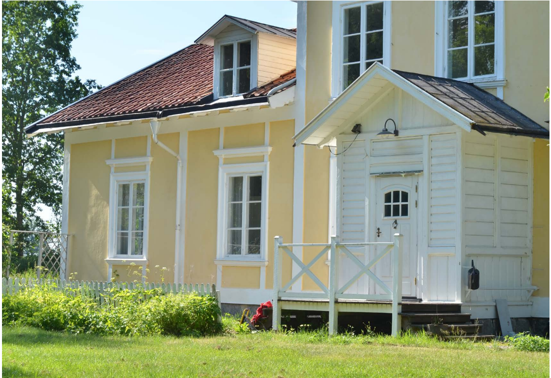
Bild 29. Södra verandan före renoveringen. Verandan har delvis moderniserats i senare tid. Verandan har isolerats på insidan och ytterdörren har bytts ut och fönsterbågar har tagits bort (SLM D2022-0875).
