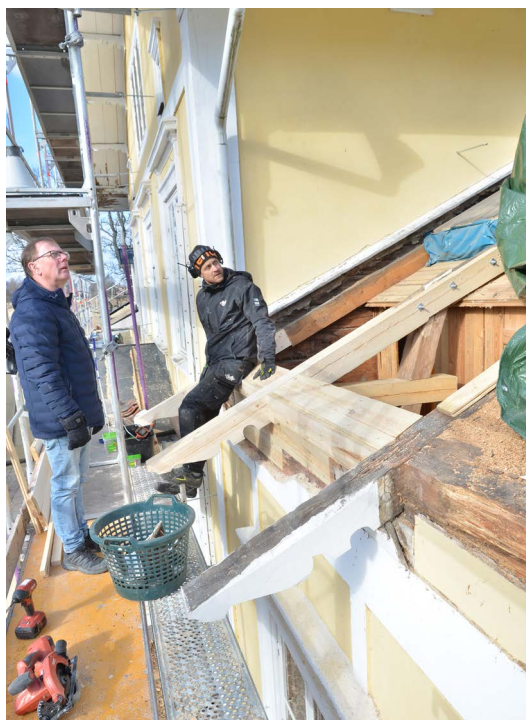
Bild 21. Under pågående trälagningar av södra takfallet, östra delen. I bild syns till vänster Mac Sandberg och Magnus Bergström, Tyrfors Bygg AB. (SLM D2022-0868).
