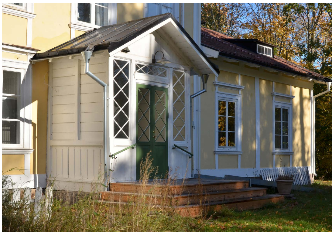
Bild 34. Södra verandan efter avslutade arbeten i oktober 2022 (SLM D2022-0878).
