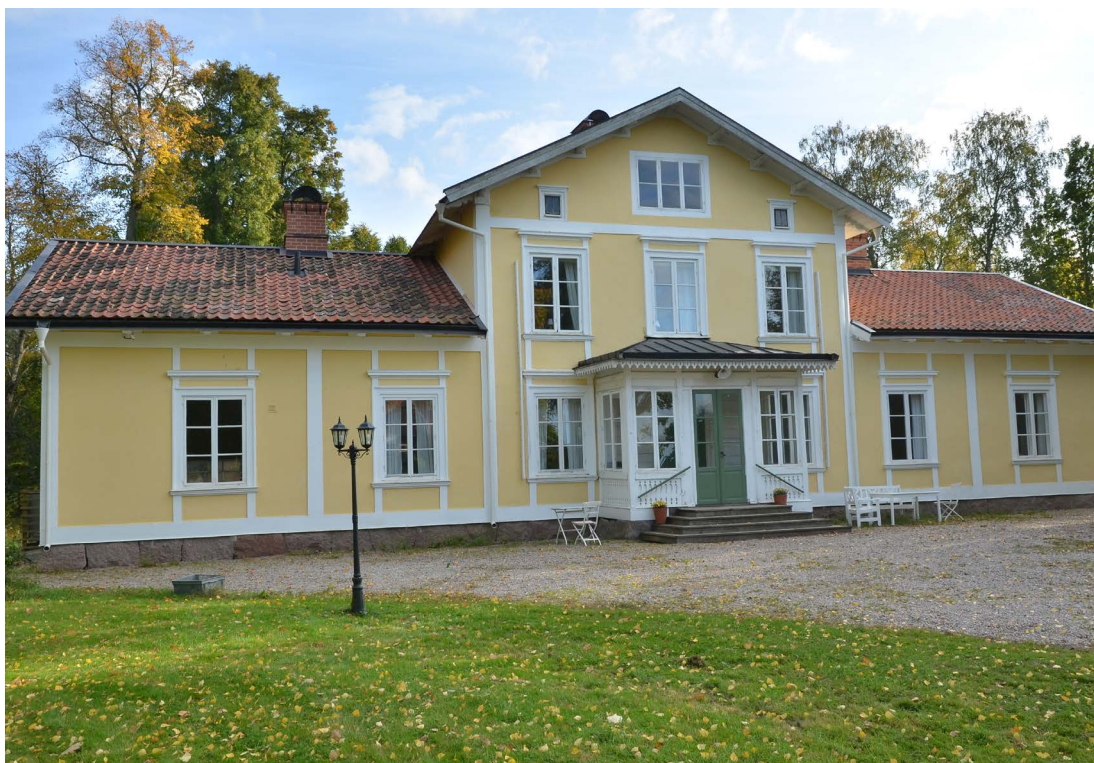
Bild 27. Byggnadens entréside efter renoveringen. Notera att stuprören har flyttats och utseendet har ändrats. Jämför bild 8. (SLM D2022-0873)
