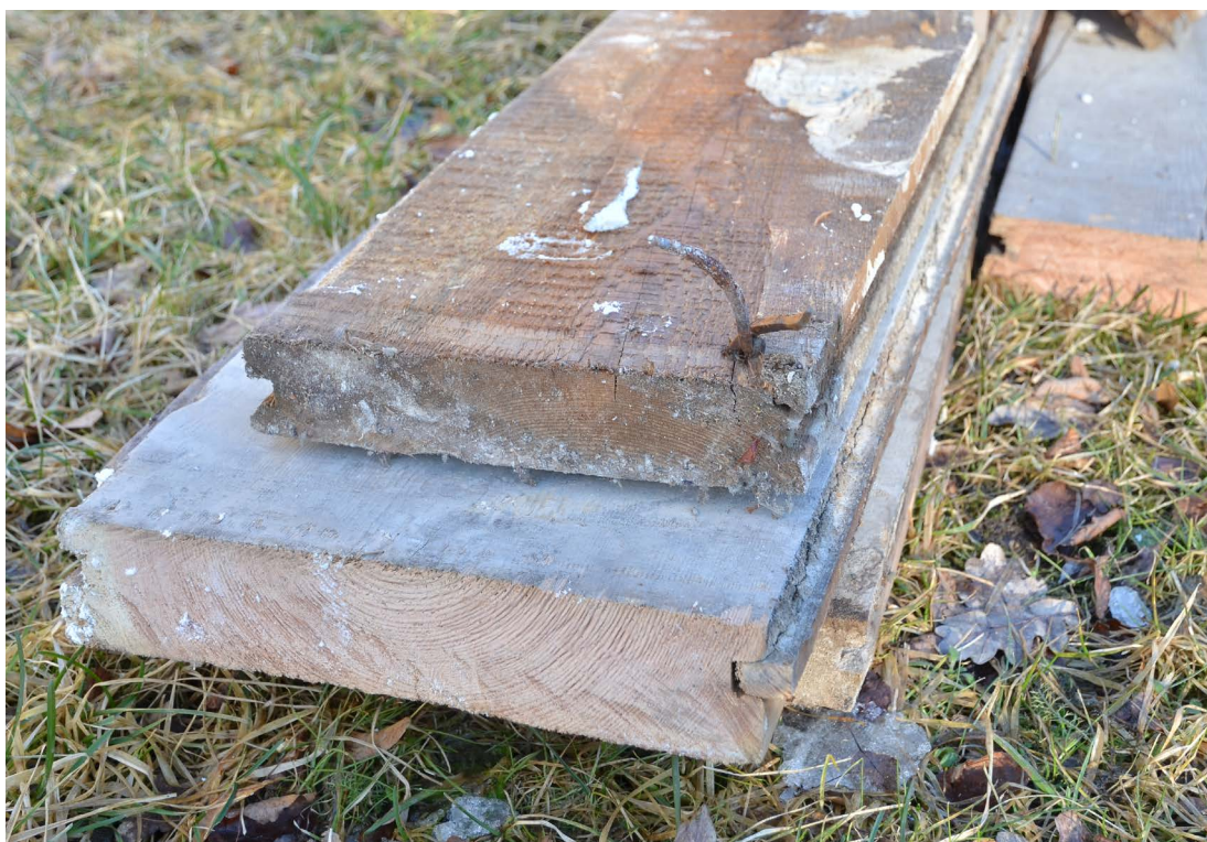
Bild 38. Detalj av golvplank som legat i köket. Underst ligger den äldsta golvbrädan 290x60 mm, med lös spont och i tätvuxet virke. Ovanpå ett nyare spontat trägolv, 90x35 mm (SLM D2022-0882).
